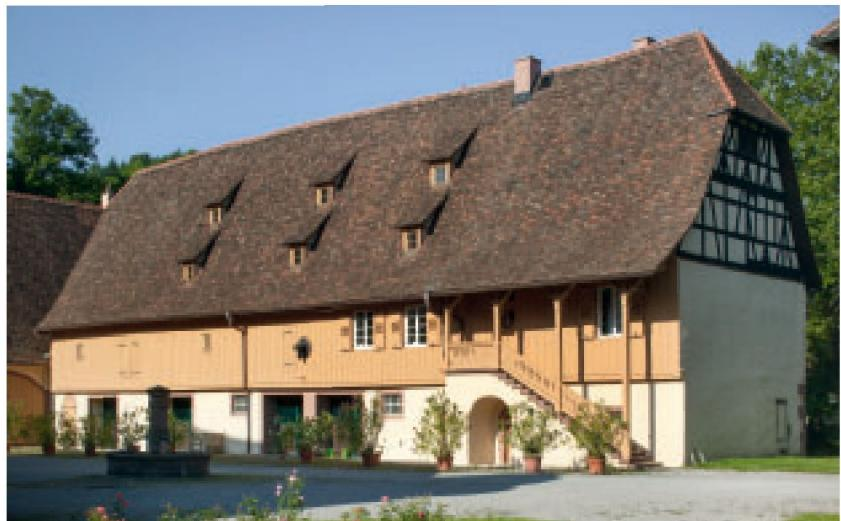
änderungen. Auf dem massiv gemauerten Erdgeschoss wurde das Obergeschoss in Fachwerk errichtet (Abb. 6). An der dem Park zugewandten rückwärtigen Fassade lassen die wechselnden Holzkonstruktionen, die unterschiedlichen Profilierungen des Traufgesimses sowie die verschiedenen Fensterformate auf mehrere Bauabschnitte schließen (Abb. 7). Auf eine bauhistorische Unter-
