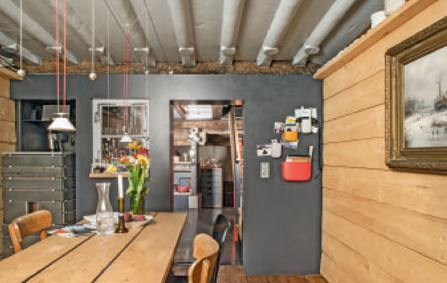
9 Rückwärtige Stube im Hochparterre mit bauzeitlicher Bretter-Balken-Decke und modernen Bohlenwänden, zugleich Schutz für die dahinterliegenden Wandbefunde. Blick in die mittlere Raumzone mit neuer Küche, 2016.
