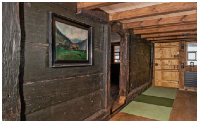
5 Hausgang im Erdgeschoss, bauzeitliche Bohlenwand der Stube.
