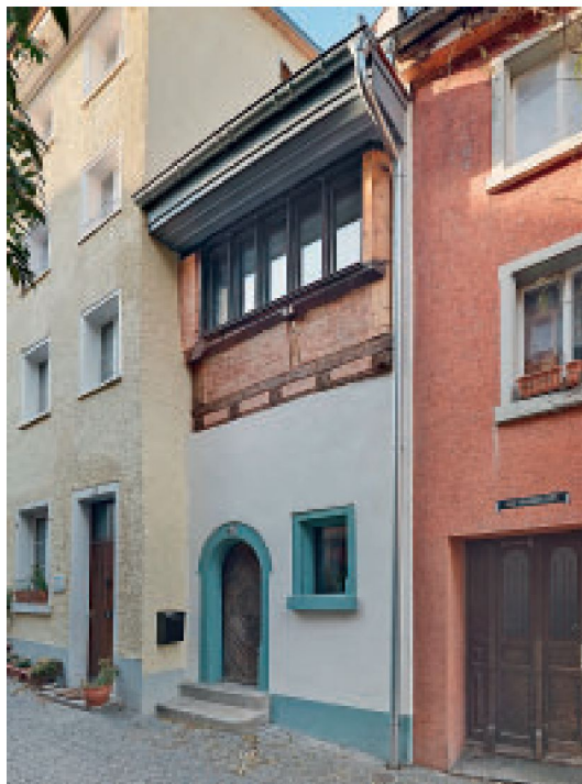
1 Fassade nach der Instandsetzung mit freigelegtem Fachwerk und wiederhergestelltem Fenstererker.
