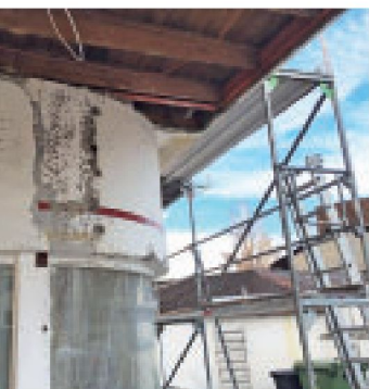
10 Der Befund zum Kontraststreifen an der gerundeten Nordwestecke nach Rückbau der Reste des Anbaus aus den 1970er Jahren.
