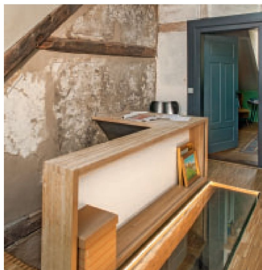
11 Südlicher Giebel im Dachgeschoss mit Resten der das mittelalterliche Fachwerk nachzeichnenden Renaissancefassung; in Lehm neu verputzt zeichnet sich die renaissancezeitliche Aufstockung ab, 2017.
