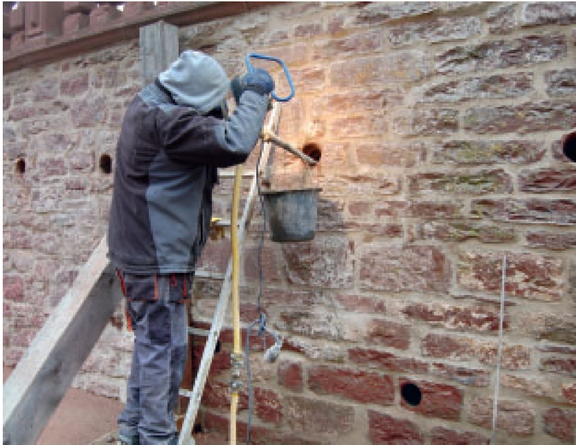
5 Bohrungen für Zuganker nach Vorgabe des Statikers. Die Bohrlöcher wurden anschließend geschlossen.
