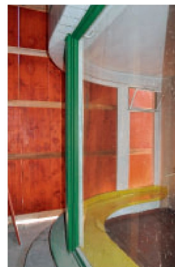
7 Das abgerundete Fensterband der Nordfassade zum Zeitpunkt der Bestandsaufnahme 2013. Hier gut zu erkennen das Prinzip der durchgehenden Fensterbank.
