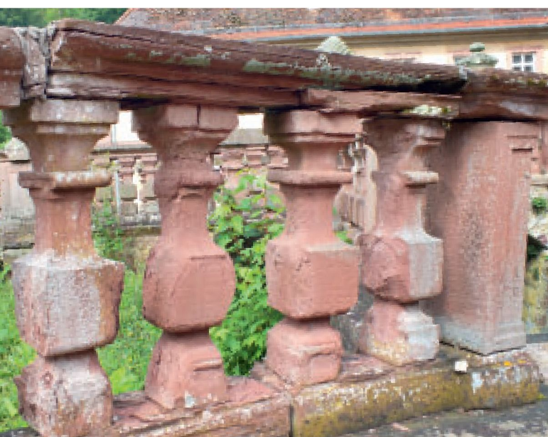
7 Die Balustrade aus rotem Buntsandstein nach der restauratorischen Maßnahme.
