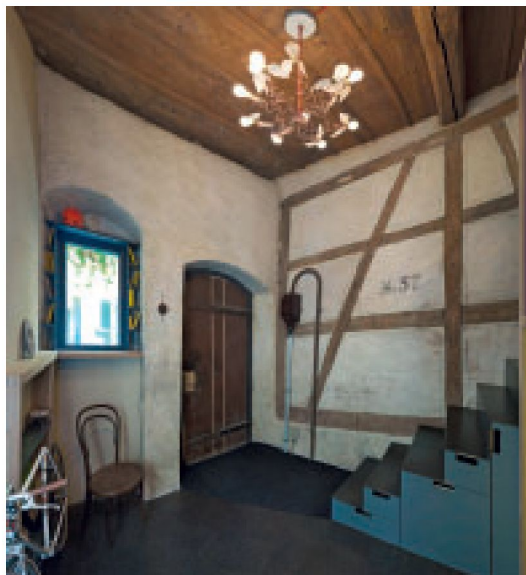
7 Freigelegte „Eingangshalle“ mit gesicherter Renaissancefassung an massiver Außenwand und am Fachwerk der südlichen Giebelwand, 2016.
