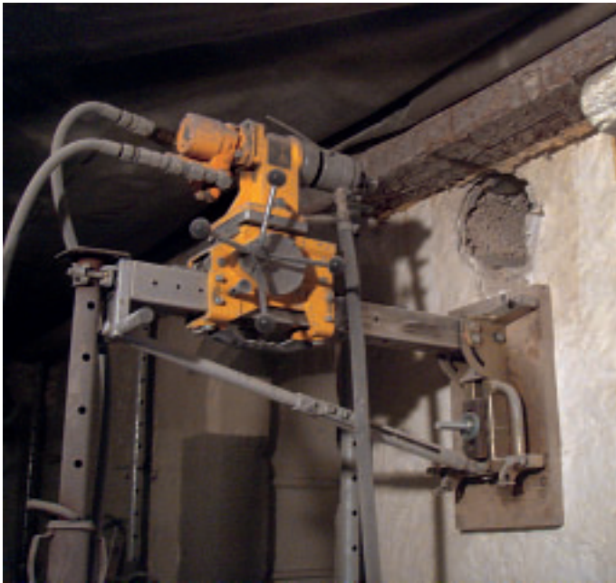
7 Maschinenaufbau während der Herstellung der Kernbohrung für eine Stahlkonsole in der Ostwand der Eingangshalle von Marktstraße 45.
