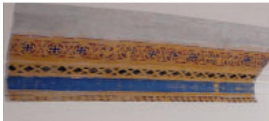
Mithilfe einer Schablone Ende des 19. Jahrhunderts aufgemalter Fries in einem der Räume.
