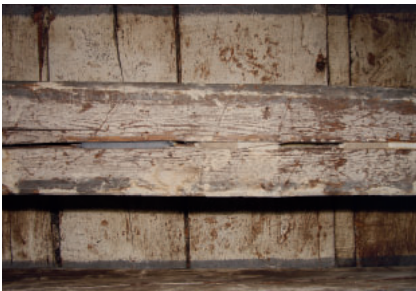
13 Arbeitsprobe mit den verschiedenen Materialien in situ: links im Rissverlauf die graue Promaseal-Kittung, rechts daneben zwei unter Niveau liegende Gipskittungen, die jeweils im linken Teil retuschiert wurden.
