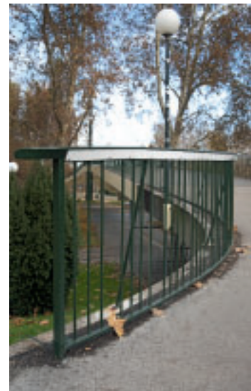
7 Geländer des Fußgängersteiges mit Kunststoffabdeckung des Handlaufholms.
