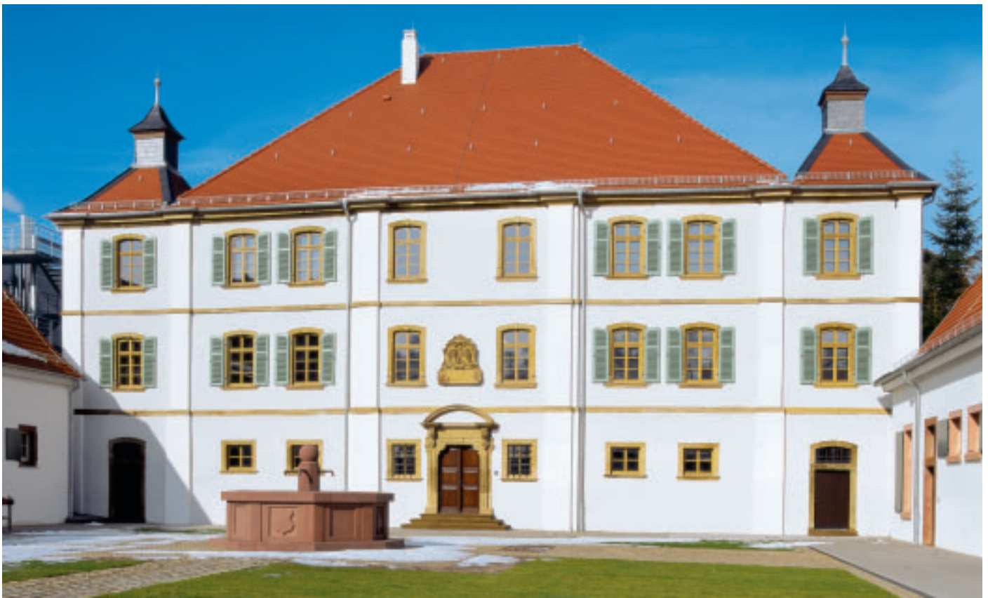
3 Das Herrenhaus nach der Sanierung.
