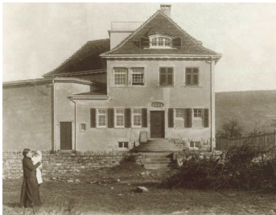
1 Hauptseite zum Garten mit Terrasse, Hauseingang und Loggia, kurz nach Fertigstellung, um 1905.
