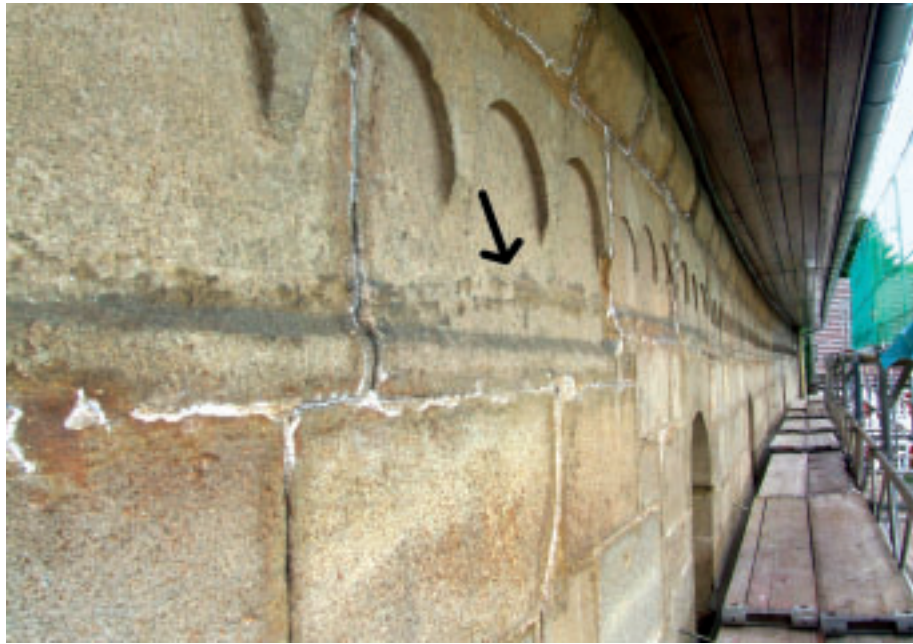
10 Obergadenwand Nord, Blick von Ost, 2009. S-förmiger Wandverlauf aufgrund von Verformungen. Putzlinie als Anschlag eines früheren Seitenschiffdaches (Pfeil).
