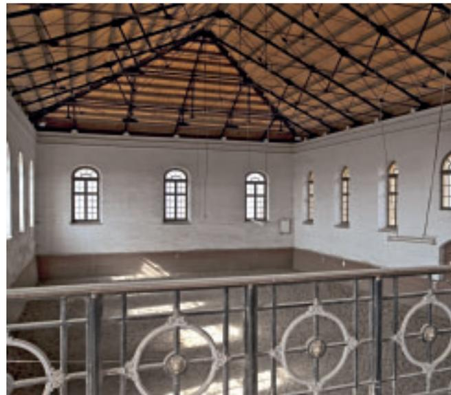
andererseits Bedenken wegen der statischen Tragfähigkeitsnachweise hervorriefen und zudem zu befürchten war, dass das Tragwerk durch Feuchtigkeit aus dem schadhaften Dach bereits Korrosionsschäden haben könnte. Aus den erwähnten Gründen wurden daher zunächst restauratorische und baugeschichtliche Untersuchungen an der Reithalle durchgeführt, um so nähere Kenntnisse zum Bestand und Grundlagen für eine fachgerechte Instandsetzung zu gewinnen.
