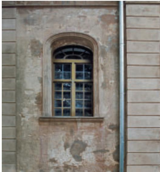
beim umfangreichen Fensterbestand aus. Offensichtlich waren an den Fenstern seit vielen Jahrzehnten keine Wartungs- und Instandsetzungsarbeiten mehr durchgeführt worden. Die lange Vernachlässigung und dauernde Durchfeuchtung der Holzsubstanz hatten trotz der verwendeten Eiche in Teilbereichen eine humusartige Holzkonsistenz erzeugt.
