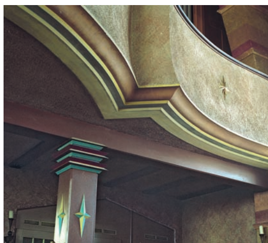
8 a–d Kuchen, katholische Heilig-Kreuz-Kirche, 1975 abgebrochen. Details des Innenraums: Bogen in der Chornische, nördliches Chorfenster, Kanzel an der Nordwand und Empore im Westen.
