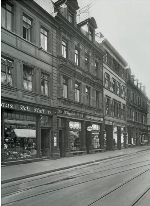
8 Gründerzeitliche Wohn- und Ladenhäuser in der Hauptstraße, Foto um 1920.
