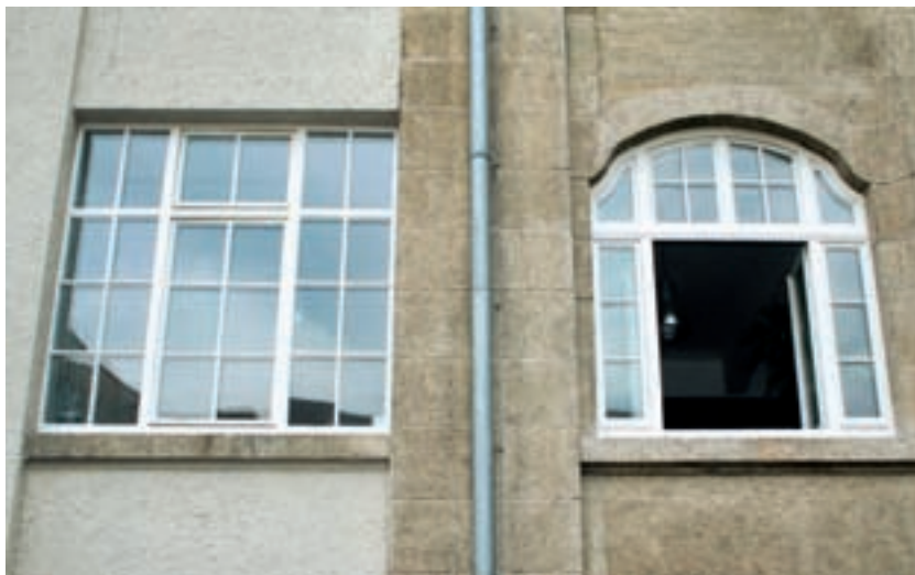
6 Ulm, Römerstraße 21; Bauaufnahme bauzeitliches Verbundfenster.
