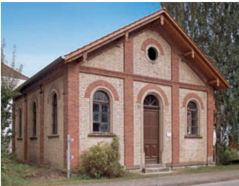
9 Die ehemalige Synagoge in Sinsheim-Steinsfurt. Eingangsfassade.
