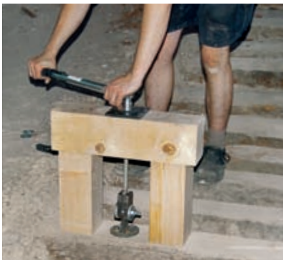
9 Montage der neuen Deckenaufhängung am ersten Stahlträger; im Vordergrund die Kernbohrungen im Lehm Schlag.
