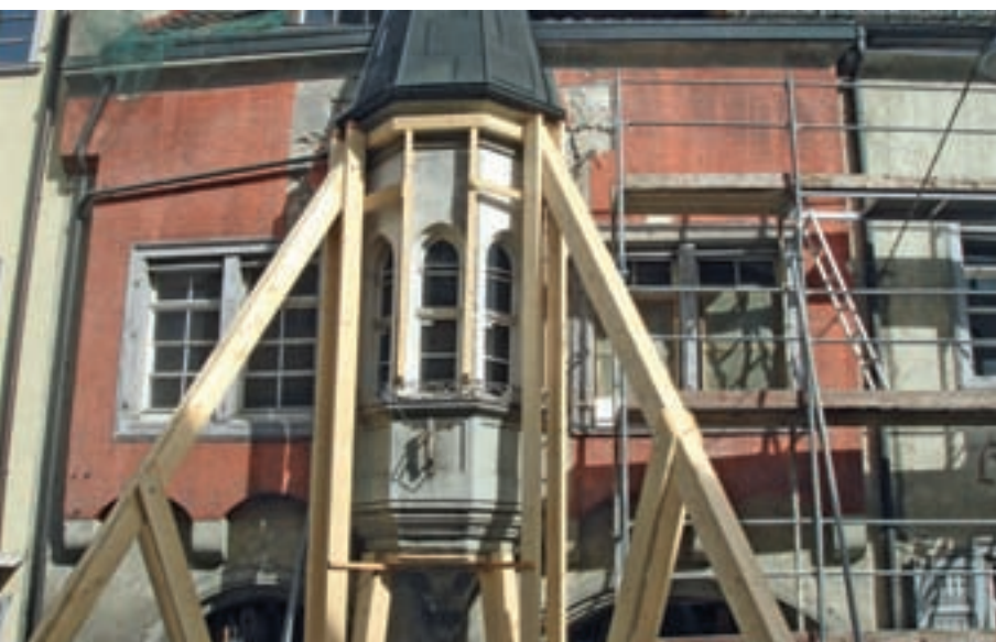
5 Fassade mit Sicherung des Erkers, Zustand 2007.
