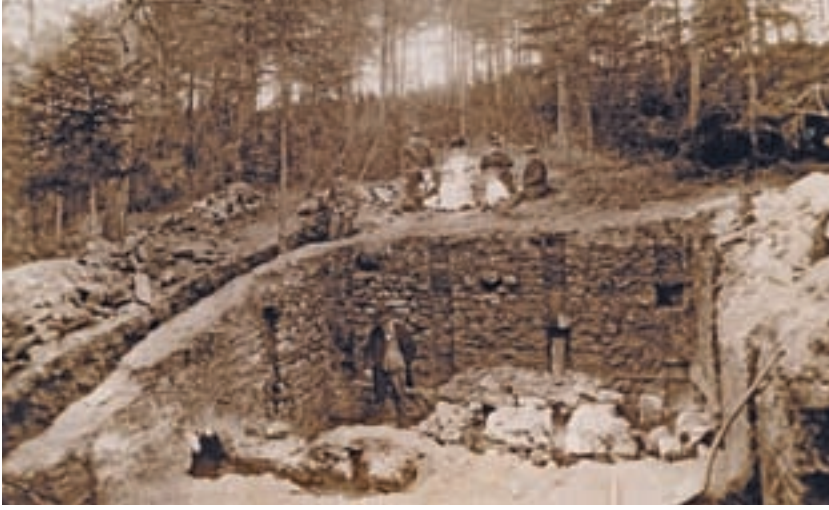
8 Die Badeanlage im römischen Gutshof von Fischbach, Kreis Rottweil. Hypokaustheizung mit Wandschächten und darin fragmentarisch erhaltener Tubulierung für den Abzug heißer Rauchgase, Aufnahme 1885.
