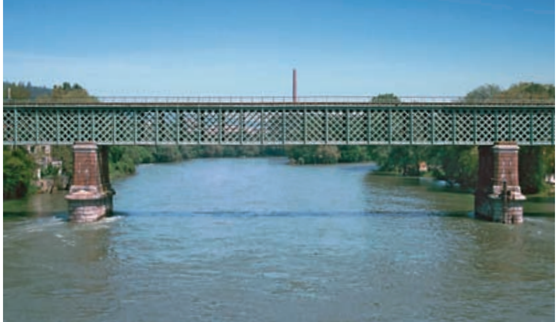
2 Eiserner Gitterträger (Ansicht von Nordwesten).
