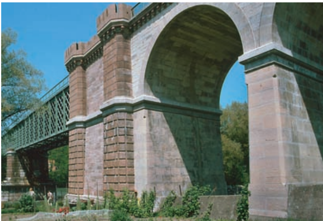
4 Naturstein-Widerlager (Koblenz – CH).
