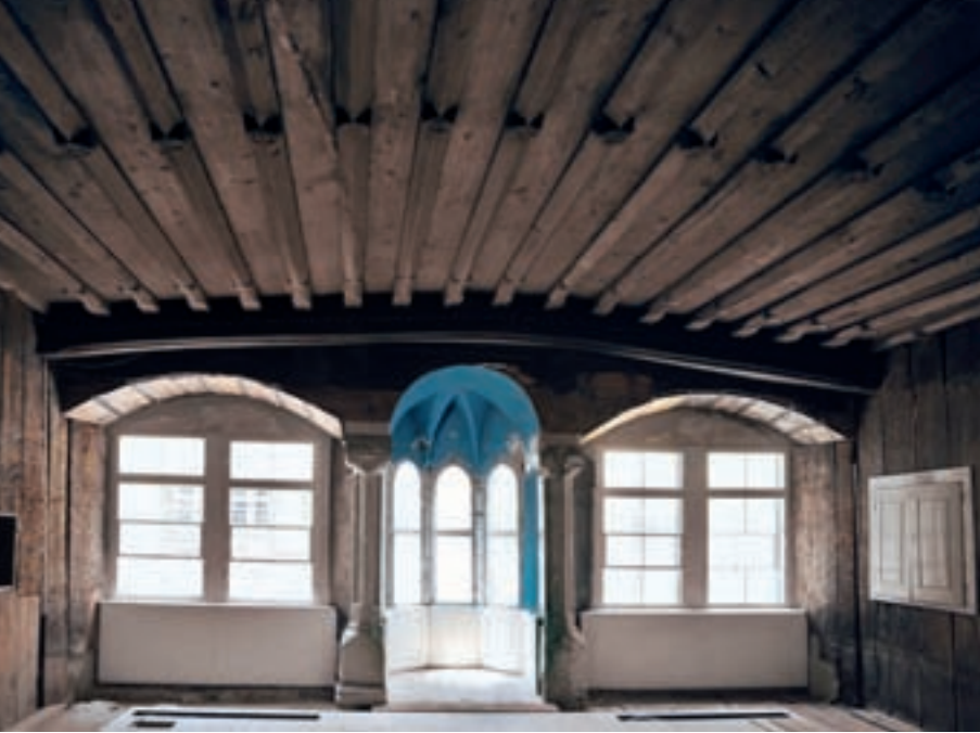
13 Erkerwand der Bohlenstube von 1435, Zustand 2009.
