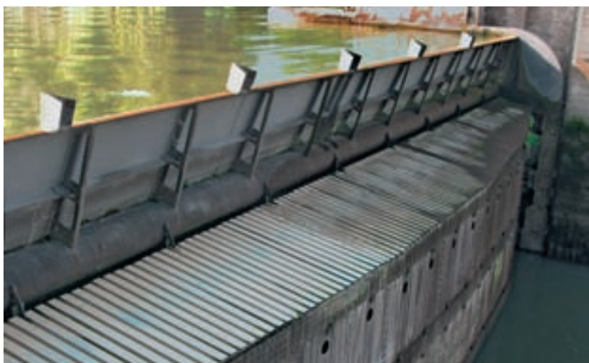
4 Aufsicht auf einen der drei Wehrverschlüsse mit Trapezblechabdeckung und Torsionsrohr, auf welchem die Aufsatzklappe befestigt ist.
