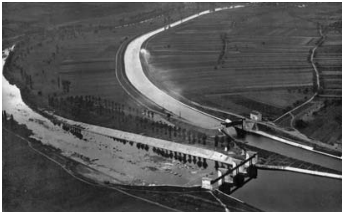
2 Das fertiggestellte Obere Stauwehr Horkheim mit Hochwasserverschluss und den Stegen am 14. Oktober 1929. Dazu gehört auch das 1926 errichtete Wehrwärterhaus mit zwei Wohnungen. Sichtbar ist auch die ökologisch sehr wertvolle Pappelbepflanzung der früheren Ausbauphase.
