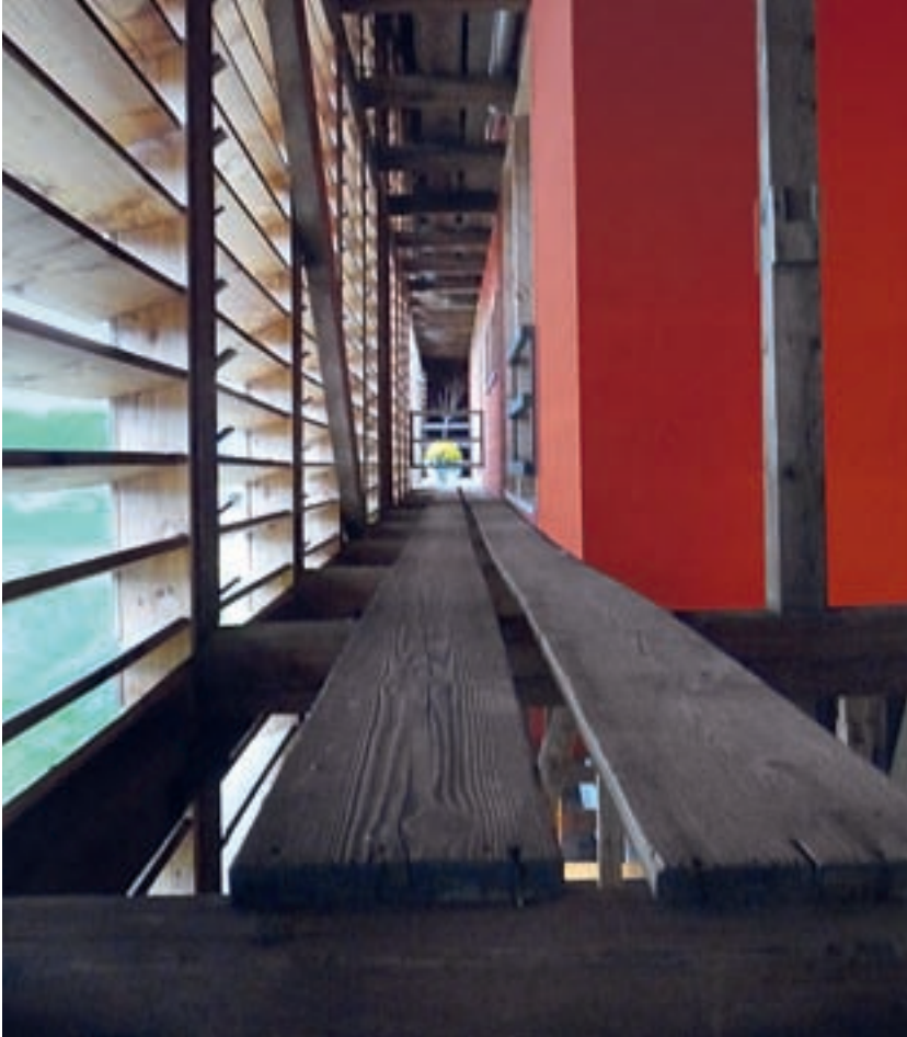
Laufgang zwischen Gebäudehülle und dem neuen Einbau.
