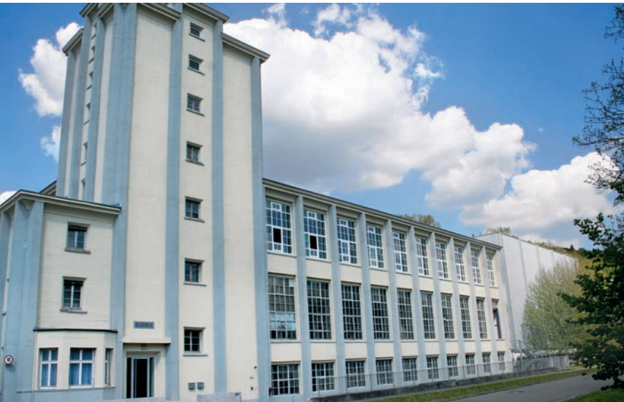
10 Tübingen, Nürtinger Str. 63. Gebäude der ehemaligen Firma Egeria.
