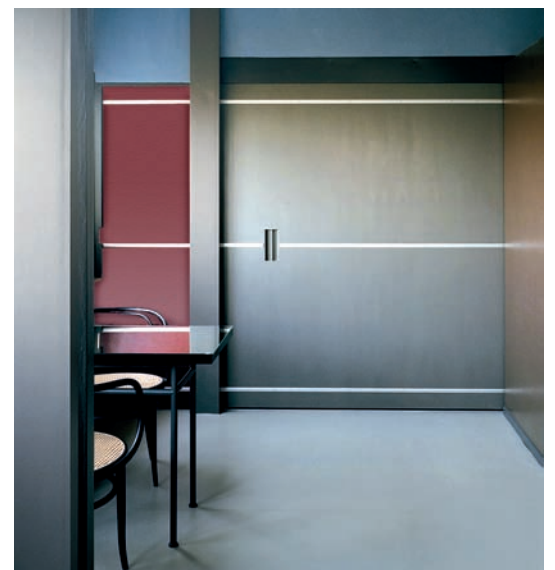
2 Nachtzustand: Abends wurden die Schiebewände geschlossen und die Betten aus den Schränken herausgezogen. Die Farbigkeit der Innenräume wurde in der rechten Haushälfte auf der Grundlage von Befunden und historischen Plänen rekonstruiert.
