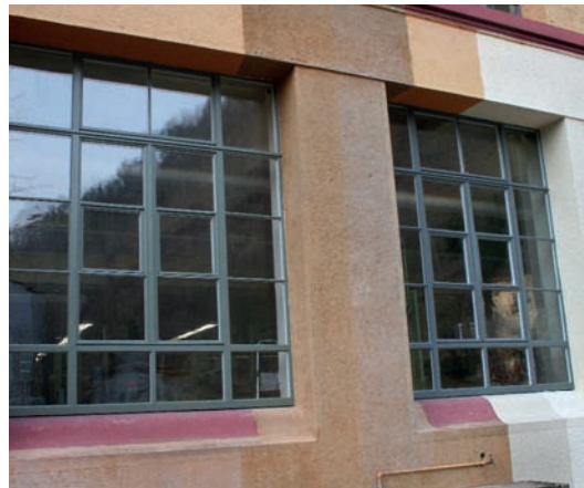
8 Schramberg, Jung- hansfabrik. Bemusterung für die Instandsetzung der Fenster und der Fas- sade.
