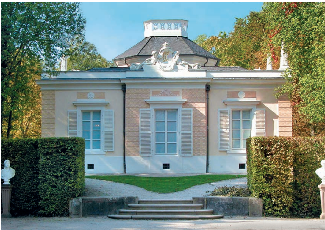
1 Ostfassade nach der Restaurierung. Das mittlere Wandfeld tritt risalitartig etwas hervor, auf der Attika darüber ein plastischer Aufbau eines von Putten flankierten Ovalschilds mit Mantel- drapierung, Monogramm CT und Kurhut. Darüber Tambour mit Bekrönung.
