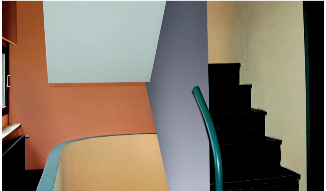
14 Rekonstruierte Decken- und Wandfassungen der bauzeitlichen Farbgebung von 1927 im Treppenhaus der Haushälfte Rathenaustraße 3.
