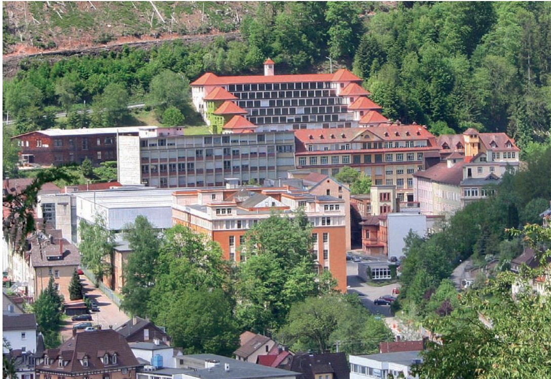
7 Schramberg, Gais- halde, Junghansfabrik mit Terrassenbau von Philipp Jakob Manz.
