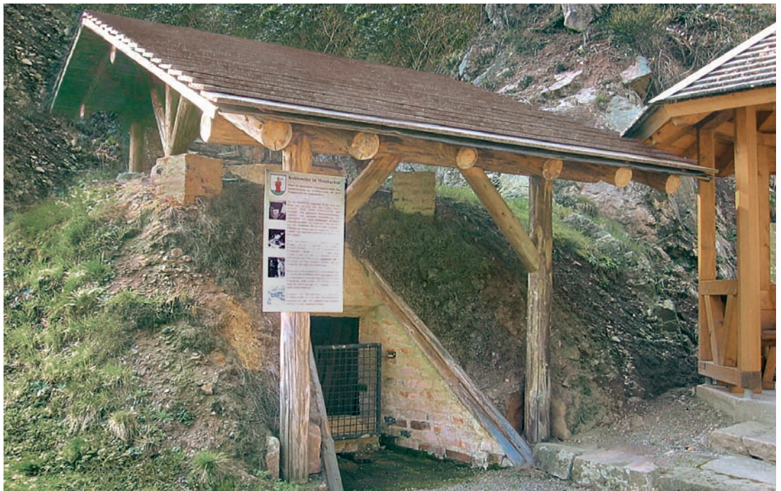
1 Zustand des Nordrachener Salveofens nach der Instandsetzung 2003.
