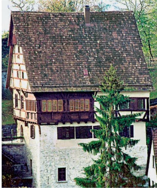
13 Vertikalschiebefenster („fenêtre à coulisse“) mit großzügiger Rechteckverglasung. Bis ins ausgehende 17. Jahrhundert wurden in Süddeutschland noch runde, in Blei gefasste Scheiben eingebaut.
