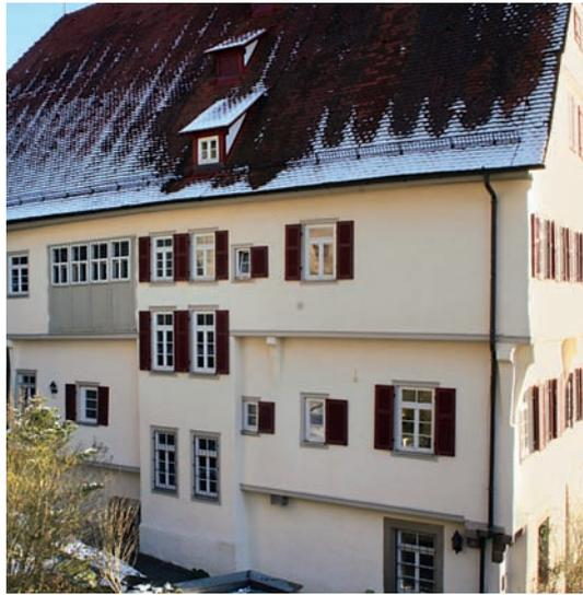
8 Herrenberg, Schlossberg 1, Evangelisches Dekanat. Fensterband von 1577 mit vollständig erhaltenen Fenstern und Ziehläden. Zusätzlich wurden um 1920 zum Schutz der Renaissancefenster und für die wärmetechnische Verbesserung Vorfenster außen in die Ebene der Ziehläden eingestellt.
