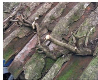
7 Außenansicht der Dachfläche. Der Efeu ist bis auf die starken, die Ziegeldeckung durchdringenden Triebe entfernt.
