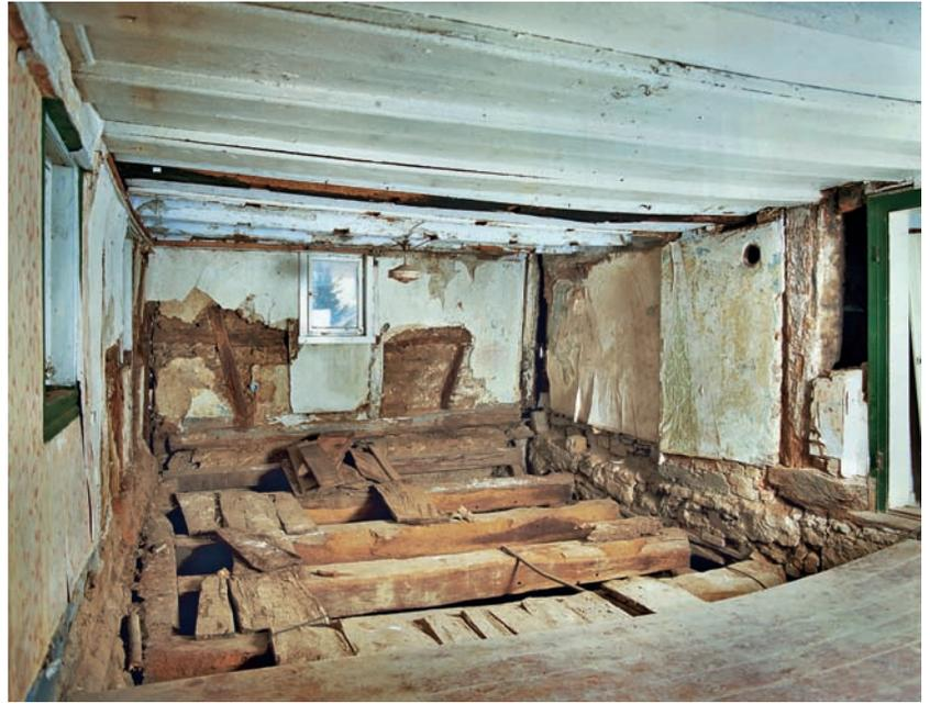
5, 6 Zu Beginn der Sanierung wurde ein moderner Fußboden entfernt und die alten Deckenbalken und Dielenbretter des 15. Jahrhunderts freigelegt. Die Verformungen und Schäden sind gut zu erkennen. Bei der Sanierung wurde die Trennwand zwischen Stube und Kammer nicht wieder errichtet. Zu sehen ist die schmale Tür, die von der Kammer in die Küche führte.
