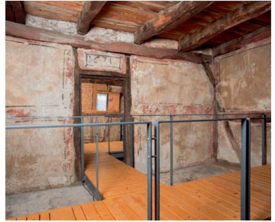
9 Obergeschoss: Die Treppe führt von der Küche ins Obergeschoss. Rechts von der Treppe ist der Rauchschirm aus Flechtwerk mit Lehmewurf zu erkennen, der verhindert, dass sich der Rauch von der Feuerstelle in der Küche ungehindert in der Diele verbreitet. Von oben ist der unterschiedliche Fußbodenaufbau von Stube und Kammer im Erdgeschoss zu sehen.
