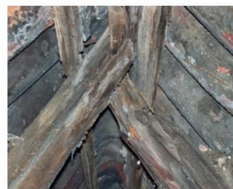
8b Rückschnitt des faulen Sparrenholzes bis zur tragfähigen Holzsubstanz (links).
