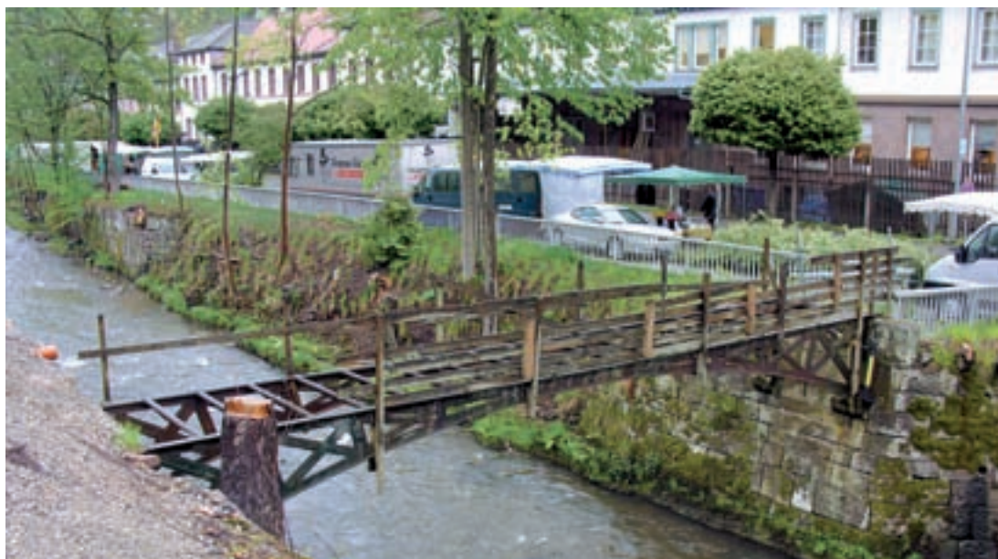
1 Gesamtansicht der Schiltachbrücke in Schramberg nach Demontage der Geländer (Zustand Mai 2006).
