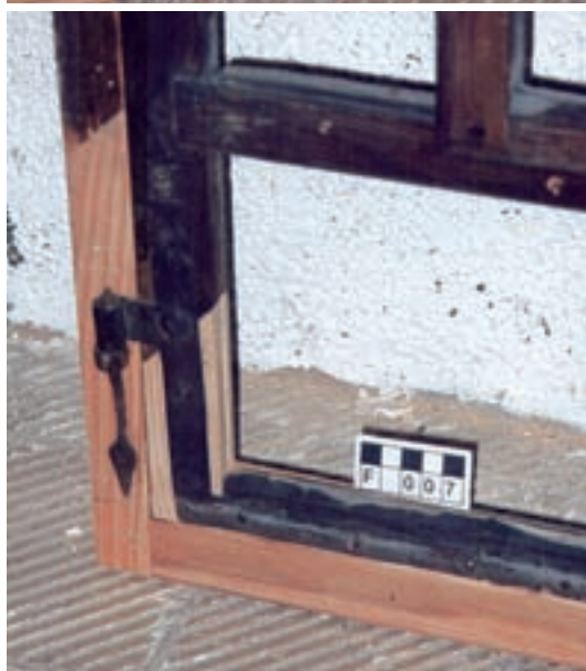
4–5 Die Reparaturstellen zeigen, dass der Holzaustausch auf das unbedingt Notwendige beschränkt wurde.
