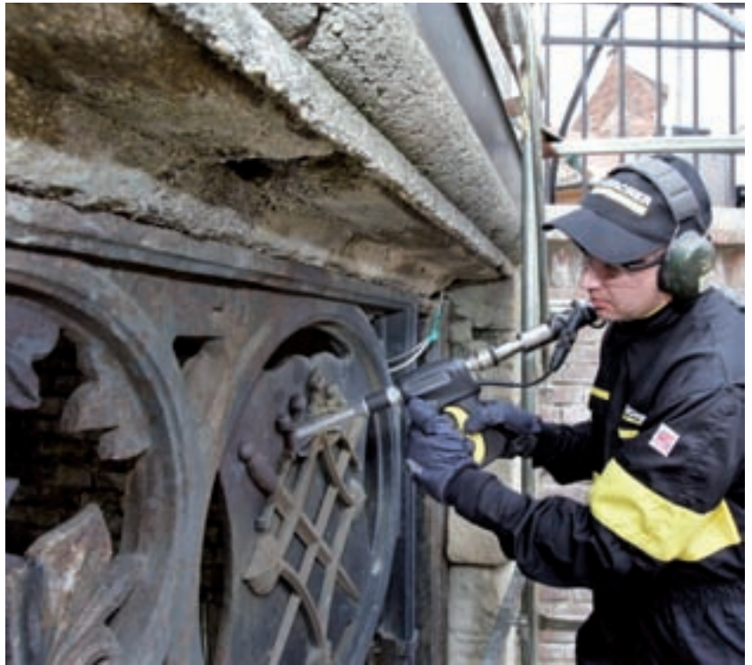
4 Anwender des Trockeneisstrahlverfahrens mit entsprechender Schutzbekleidung wie Gehörschutz, Overall, Schutzbrille oder Helm mit Sichtschutz und Handschuhen.
