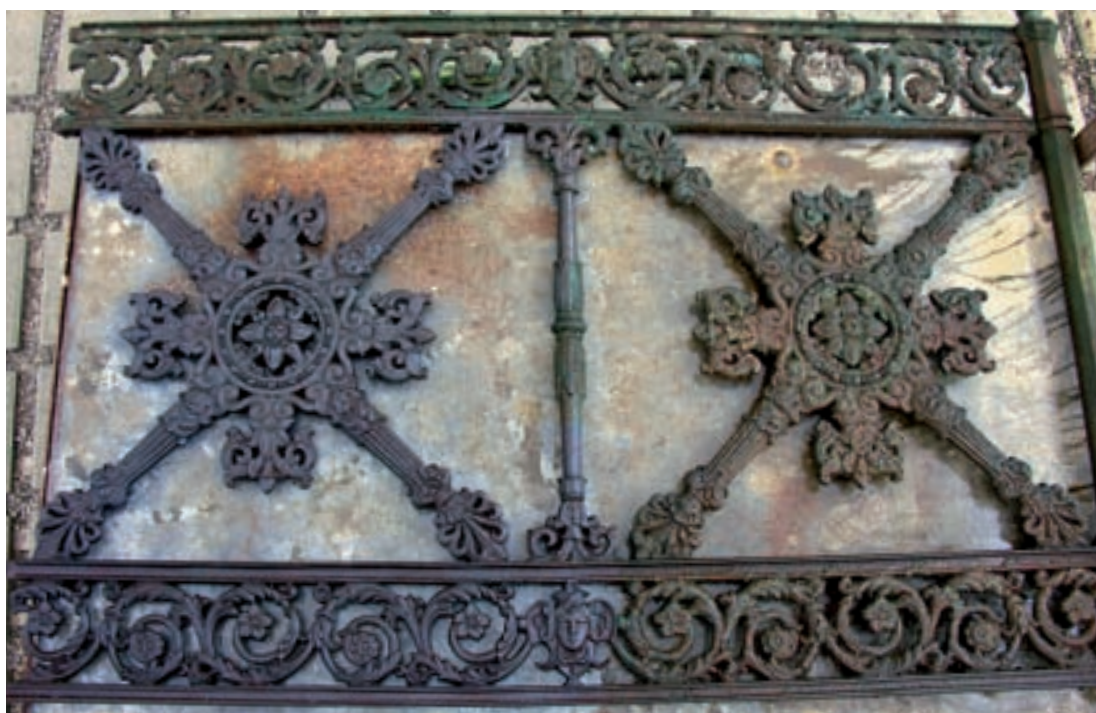
7 Geländersegment der Schiltachbrücke mit trocken-eisgestrahltem Bereich auf der linken Seite.
