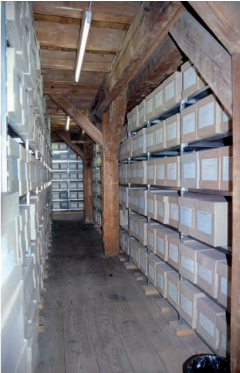
3 Rottenburg a. N., Innenansicht im 2. Ober- geschoss, Blick nach Nordwesten.
