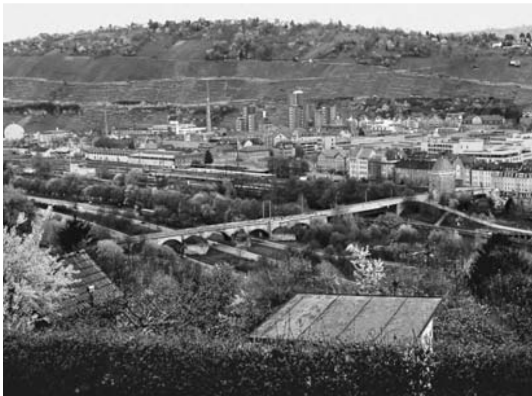
Pliensaubrücke und Pliensautor in Esslingen sind zwei Denkmalfragmente. Mehrere Bögen der Brücke mussten infolge des angewachsenen Schiffsverkehrs einem Neubau weichen. Das Tor, ehemaliger Teil der Stadtbefestigung, steht heute isoliert. Bahngleise und Straße trennen es vom Stadtkern.
