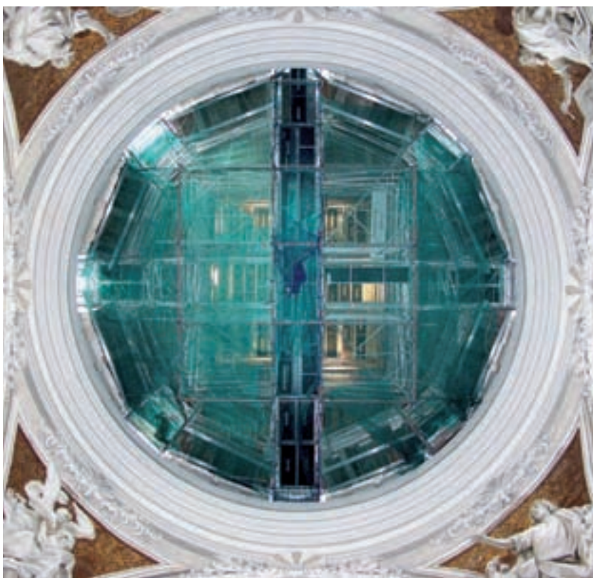
4 Die eingerüstete Kuppel von der Vierung aus gesehen.
