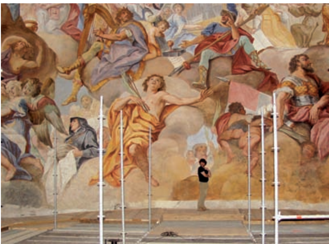
7 Kuppelansatz während der Ausrüstung, Verdeutlichung der Größenverhältnisse.
