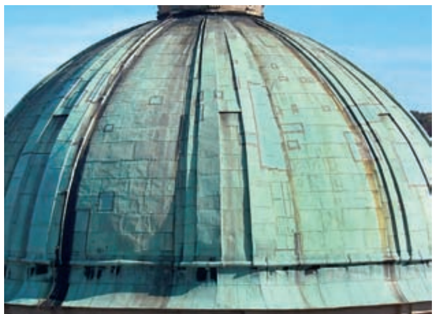
1 Blick auf die überwiegend bauzeitliche Kupferverblechung der Kuppel.
