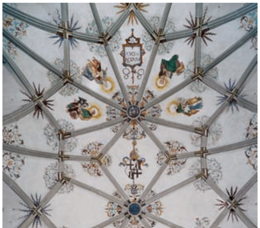
2 Chorgewölbe mit der Ausmalung von Marx Weiß d. J. von 1555, nach der Restaurierung.
