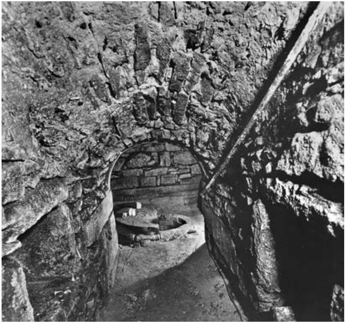
Blick aus dem Treppenschacht in den Baderaum mit dem Brunneneinbau (1978).
