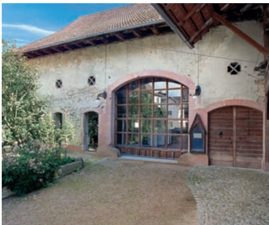
5, 6, 7 Auggen, Ellengurt. Beim Ausbau der Scheune zur Werkstatt mit Wohnbereich verzichtete der Bauherr auf zusätzliche Öffnungen in den Bruchsteinwänden und auf Dachaufbauten. Der Wohnbereich wird über das Lichtband auf der rückwärtigen Dachfläche belichtet (5), die Werkstatt über das neue Scheunentor (6). Der Innenausbau erfolgte nach dem Prinzip „Haus im Haus“ (7).
