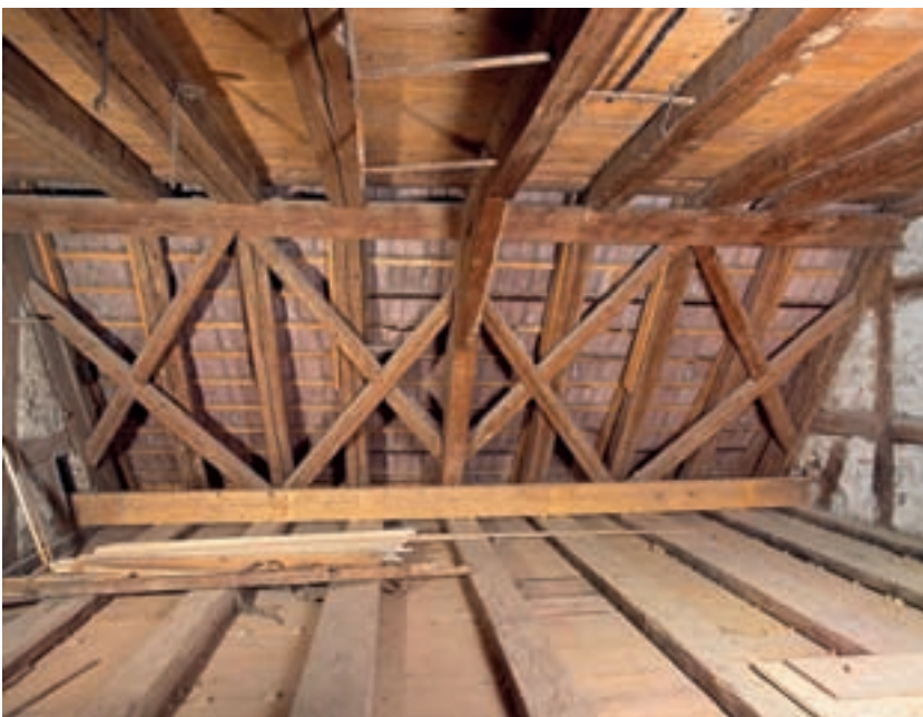
2 Der unveränderte Dachstuhl mit der bauzeitlichen Konstruktion: Typisch sind die so genannten „Andreaskreuze“ zur Windaussteifung.
