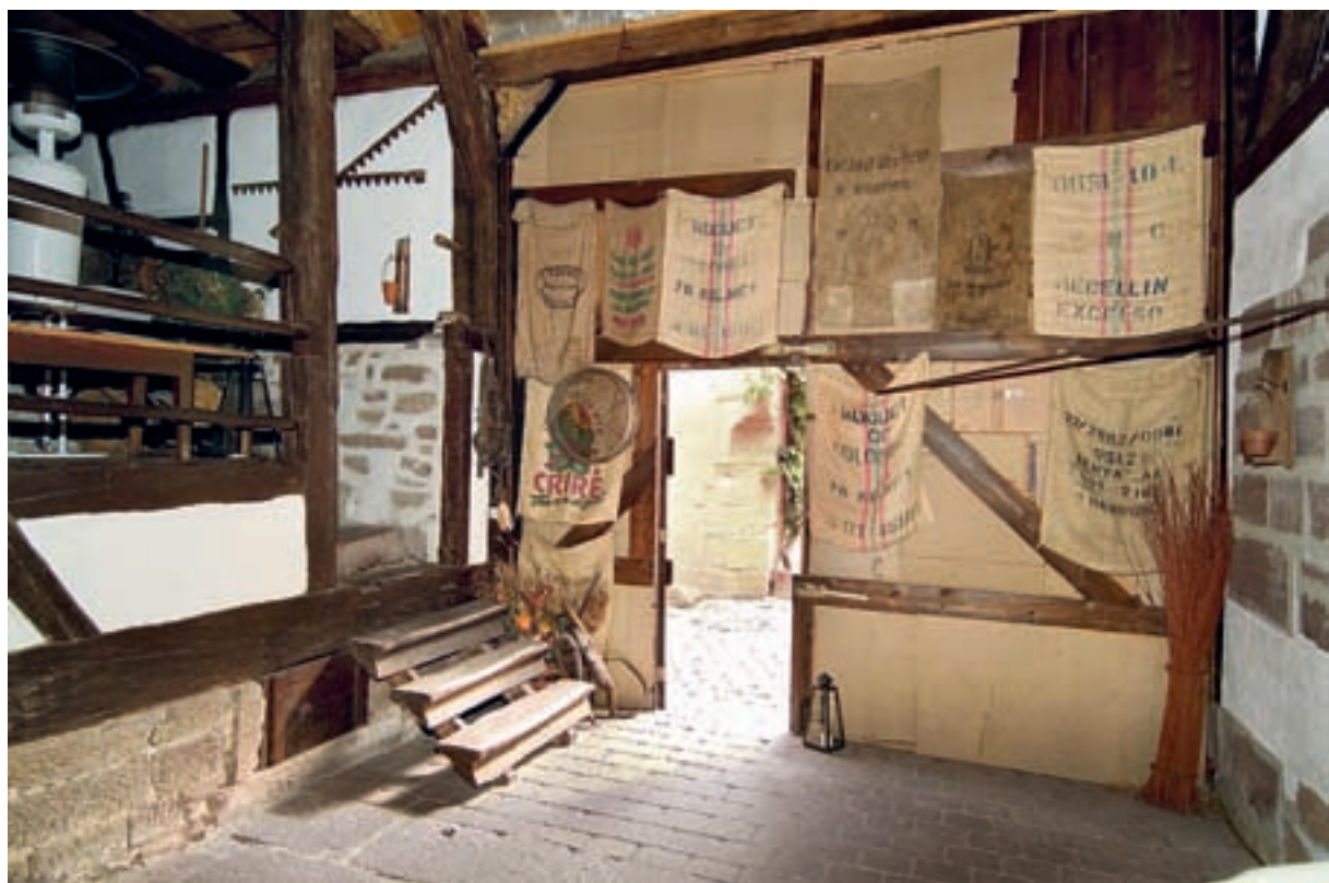
2 Die Tenne der Scheune des Gerlinger Hofes, 1997 umgenutzt zum Sommergastraum, Zustand 2007.
