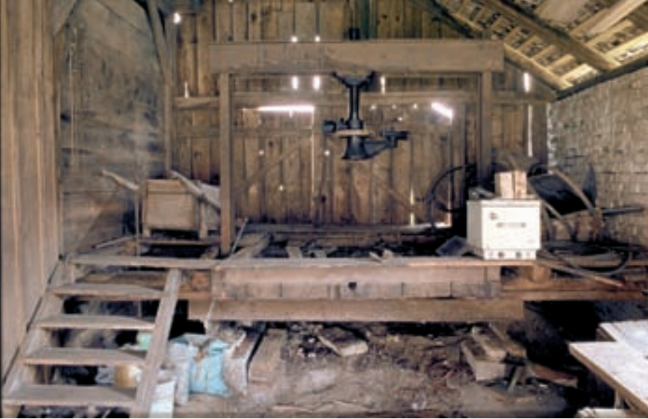
2 Die Mostpresse vor Beginn der Instandsetzung, Zustand 2007.
