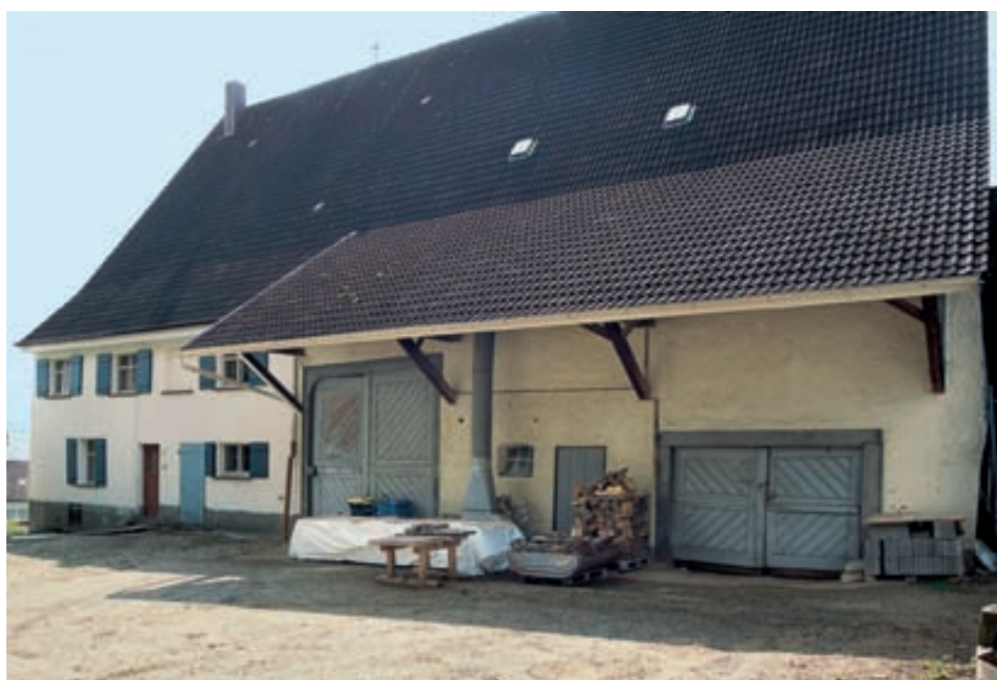
1 Das Einhaus Kirchgasse 1 in Gunningen von der Straße her. Charakteristisch für den Bautyp sind das einheitliche Dach und die ablesbaren, quergeteilten Funktionseinheiten: Wohnteil und Scheune samt Stall.
