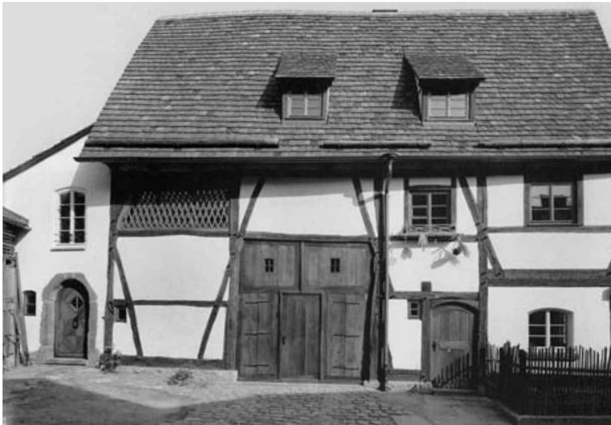
12 Rutesheim (Kreis Böblingen), Einhaus Schulstraße 8 von 1478, 1992 restauriert und ausgebaut, mit einer von der Schwäbisch Haller Hirtenscheuer angeregten neuen Belichtungsöffnung im Scheunenteil, Zustand 1992.
