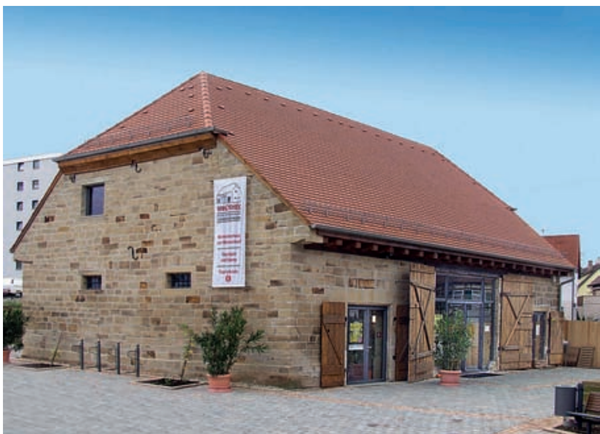
1 Die Schafscheuer nach der Sanierung im Jahr 2005.
