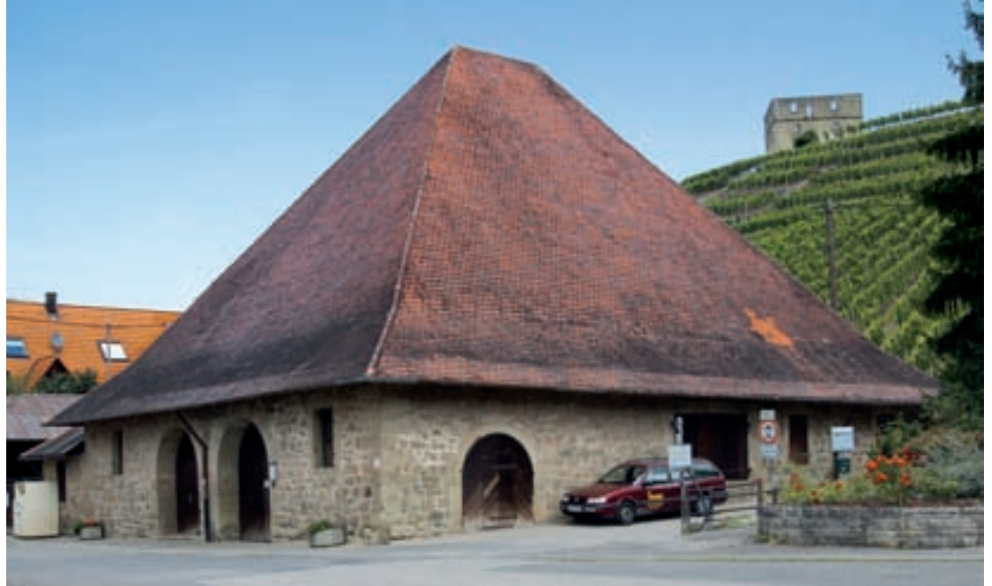
2 Kernen-Stetten, Glockenkelter. Im Hintergrund Rebenhänge und die Ruine der Yburg.
