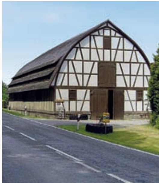
9 Hemmingen (Kreis Ludwigsburg), Schaf- und Hopfenscheune des Gutshofs Rohrsparg von 1823 mit bauzeitlichen Gaubenbändern, Zustand 2006.
