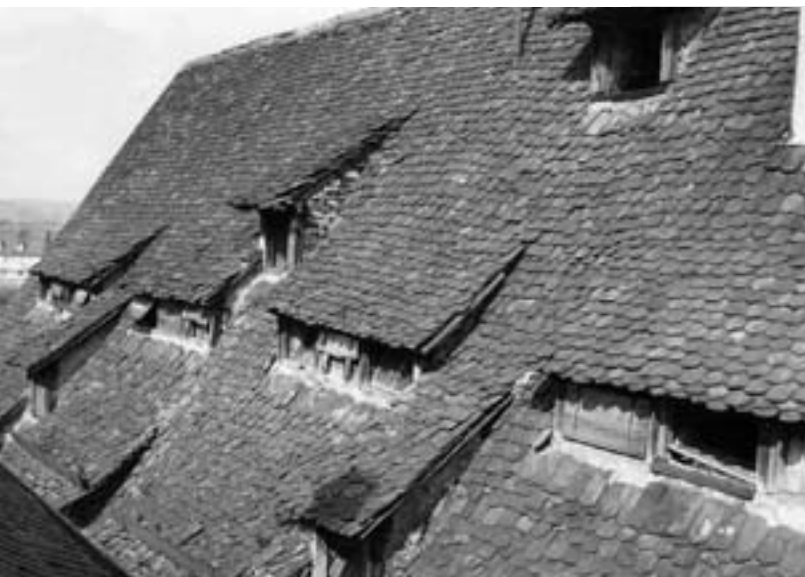
8 Weikersheim, ehemaliges Kornhaus (Marktplatz 8). Dachfläche mit niedrigen Lüftergauben in mehreren Ebenen. Zustand 1962 vor der Umdeckung.
