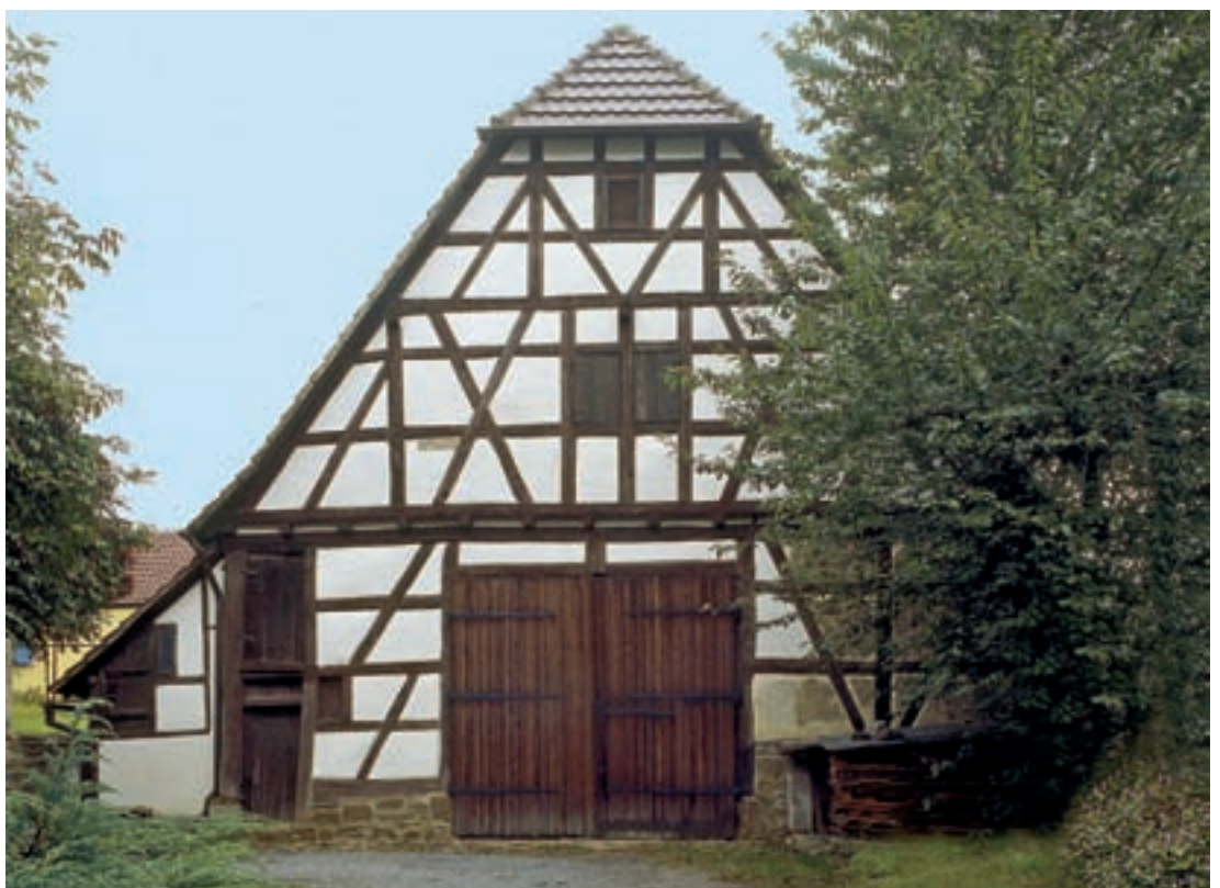
2 Ackerbürgerscheune Schlossgasse 8 von der Hofseite, Zustand 2007.
