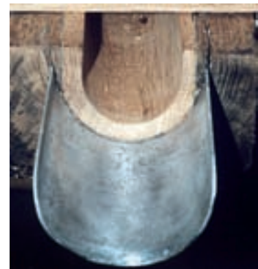
4 Der Auslauf des Pressbets nach Instandsetzung.
