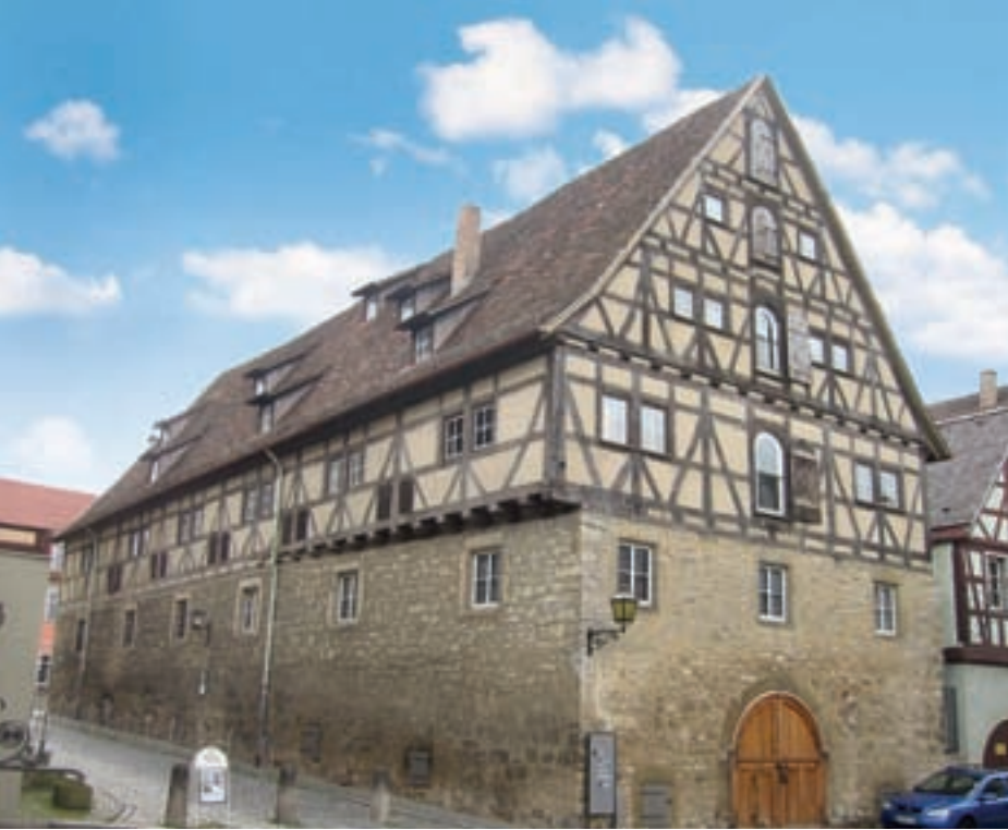
7 Weikersheim (Main-Tauber-Kreis), ehemaliges Kornhaus (Marktplatz 8) von 1582. Der platzabgewandte Giebel öffnet sich auch nach der Umnutzung zum Tauberländer Dorfmuseum in – wenn auch verglasten – Ladeluken. Zustand 2007.
