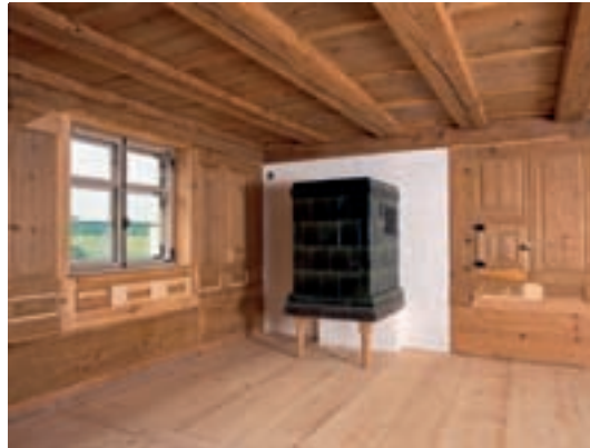
6 Die Stube im Obergeschoss nach schreinerrestauratorischer Reparatur des Täfers.
