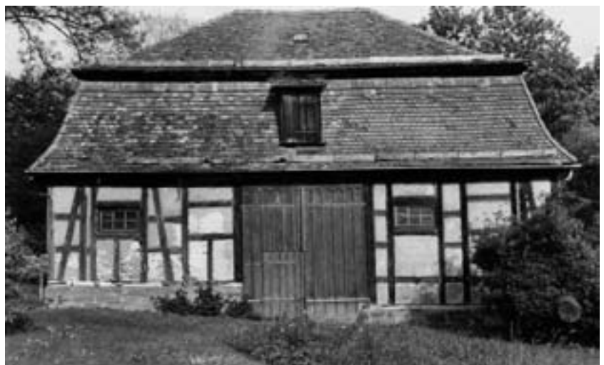
11 Stuttgart, Scheune in der Schlossanlage Solitude, Zustand im Herbst 2007 nach Instandsetzung und Umbau. Die intakten handgestrichenen Ziegel wurden nicht wieder verlegt, weil sie für die komplette Wiedereindeckung eines prominenten Gebäudes auf der Solitude vorgesehen sind.
