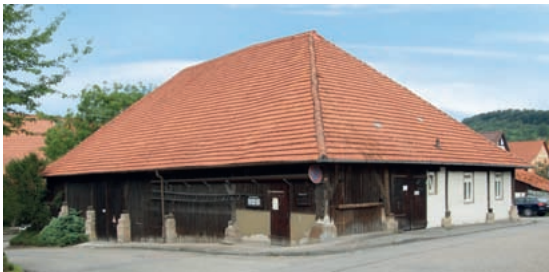
1 Schorndorf-Schornbach, Kelter. Charakteristisch sind die hohen, abgestuften Sandsteinsockel, die die Ständer der Holzkonstruktion aufnehmen.
