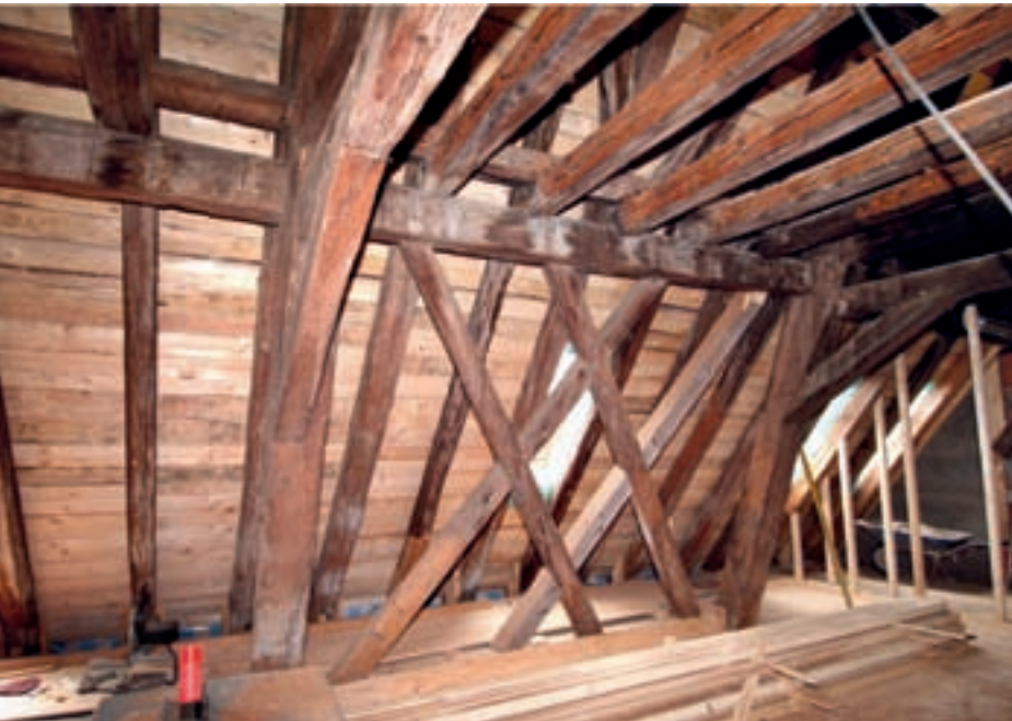
13 Kirchberg an der Murr, ehem. Stiftskelter. Erstes Dachgeschoss während der Sanierung.
