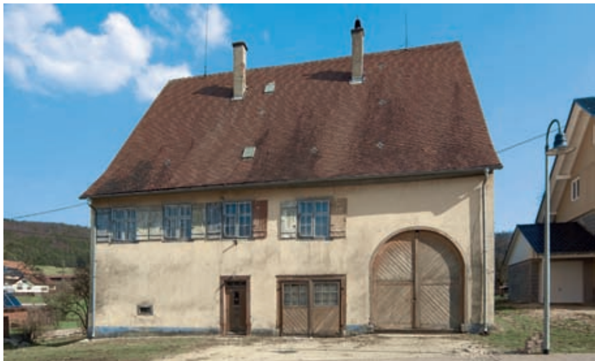
1 Straßenfassade vor der Maßnahme 2005.
