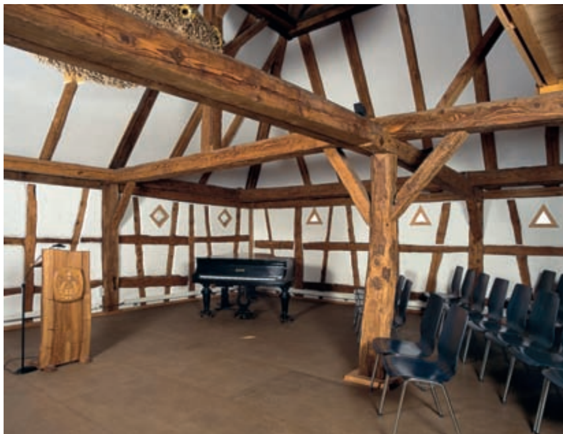
14 Veranstaltungsraum im Hörimuseum. Die Beleuchtung bestimmt den besonderen Charakter dieses Raumes. Die dekorativen Lüftungsschlitze in den Fachwerkausfachungen wurden verglast, sie sind im Bodenseeraum für die Bauaufgabe Trotte (Kelter), die hier Teil eines bäuerlichen Einhauses sein kann, charakteristisch.
