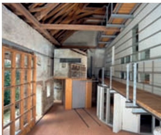
5, 6, 7 Auggen, Ellengurt. Beim Ausbau der Scheune zur Werkstatt mit Wohnbereich verzichtete der Bauherr auf zusätzliche Öffnungen in den Bruchsteinwänden und auf Dachaufbauten. Der Wohnbereich wird über das Lichtband auf der rückwärtigen Dachfläche belichtet (5), die Werkstatt über das neue Scheunentor (6). Der Innenausbau erfolgte nach dem Prinzip „Haus im Haus“ (7).
