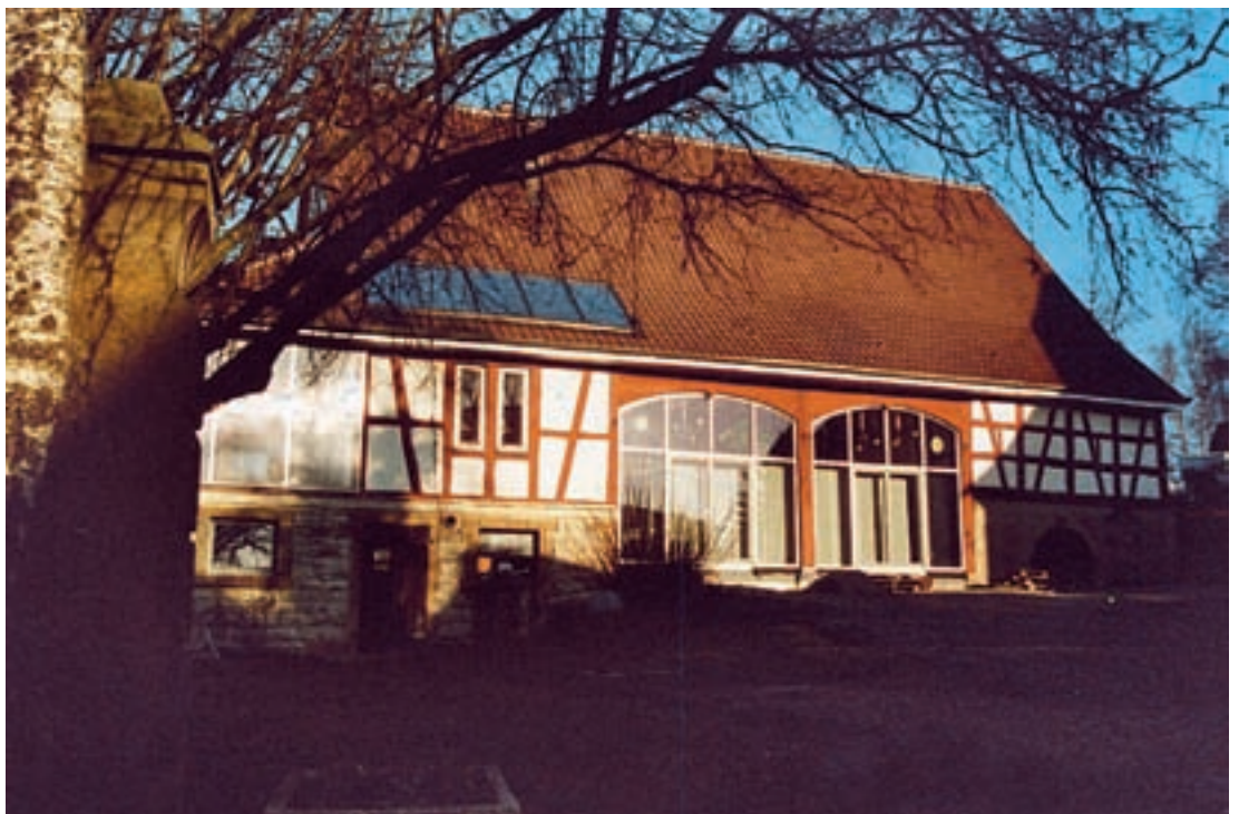
7 Scheune Schulgasse 21 in Zweiflingen nach der Umnutzung zum Einfamilienhaus 2007. Die Glaselemente in den Toröffnungen belichten den großen Wohnraum.
