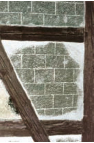
1 Gefache der Ackerbürgerscheune mit originalem Verputz in Mauerwerkstruktur, Zustand 1998.
