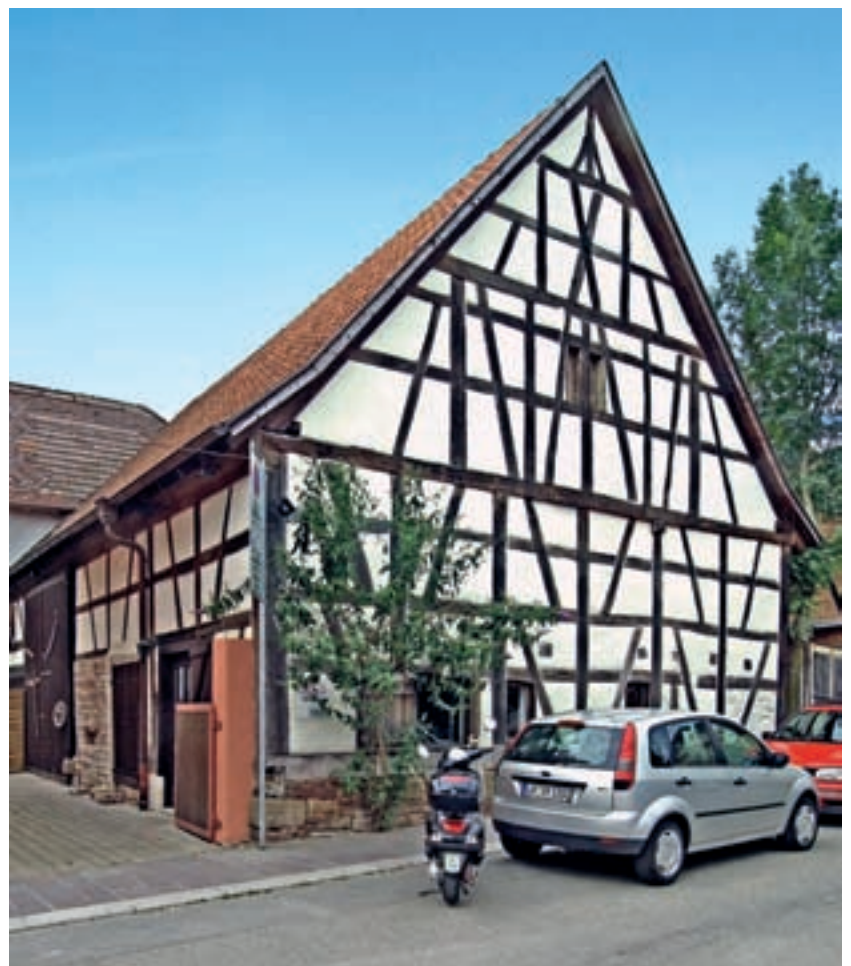
4 Die instand gesetzte Gerlinger Hofscheune von der Eltinger Straße gesehen, Zustand 2007.
