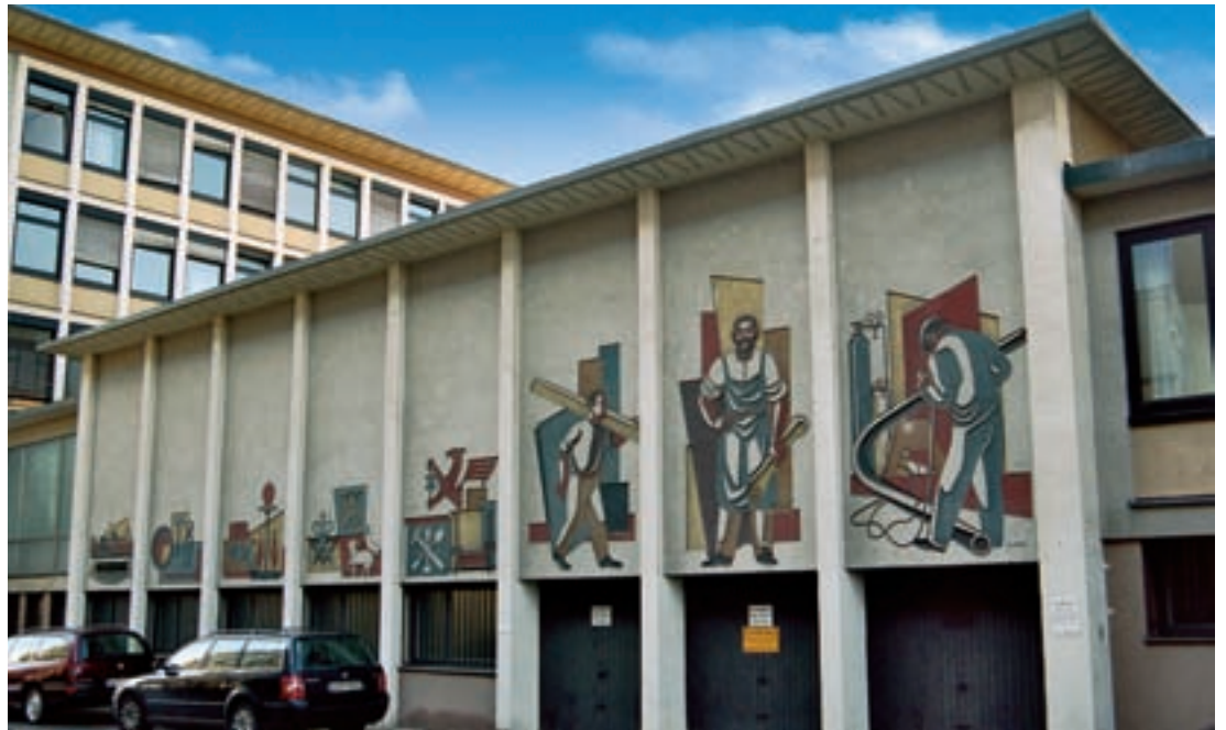
1 Handwerkskammer Ulm vor den Eingriffen, die den Abriss einleiteten.
