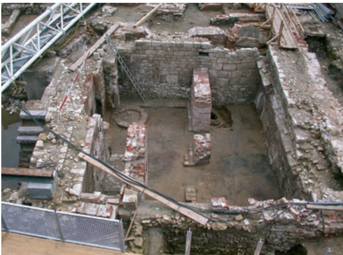
16 Ulm, Neue Straße. Blick in einen so genannten Kaufkeller am Ost- rand des Zentralmarktes, dessen Untergeschoss aus Schalenmauerwerk mit Großquadern wurde nachträglich tiefer ge- legt, unterfangen und eingewölbt.
