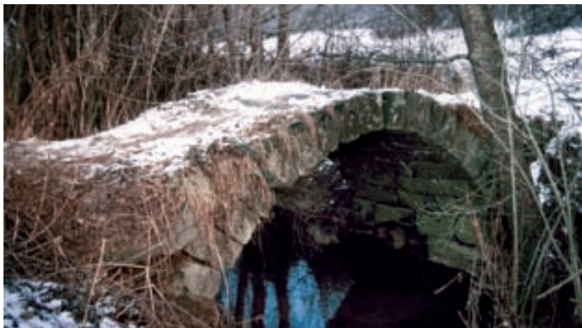
21 Brücke, Oberstenfeld, LB.
