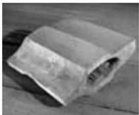
12 Ein für das Gewölbe gefertigtes Segment einer Ziegelrippe.
