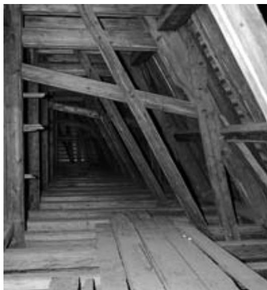
1 Breite, sehr steil verlaufende Fußbänder fixieren die liegenden, aus gesägtem Eichenholz gefertigten Stuhlstützen im Chordachwerk.
