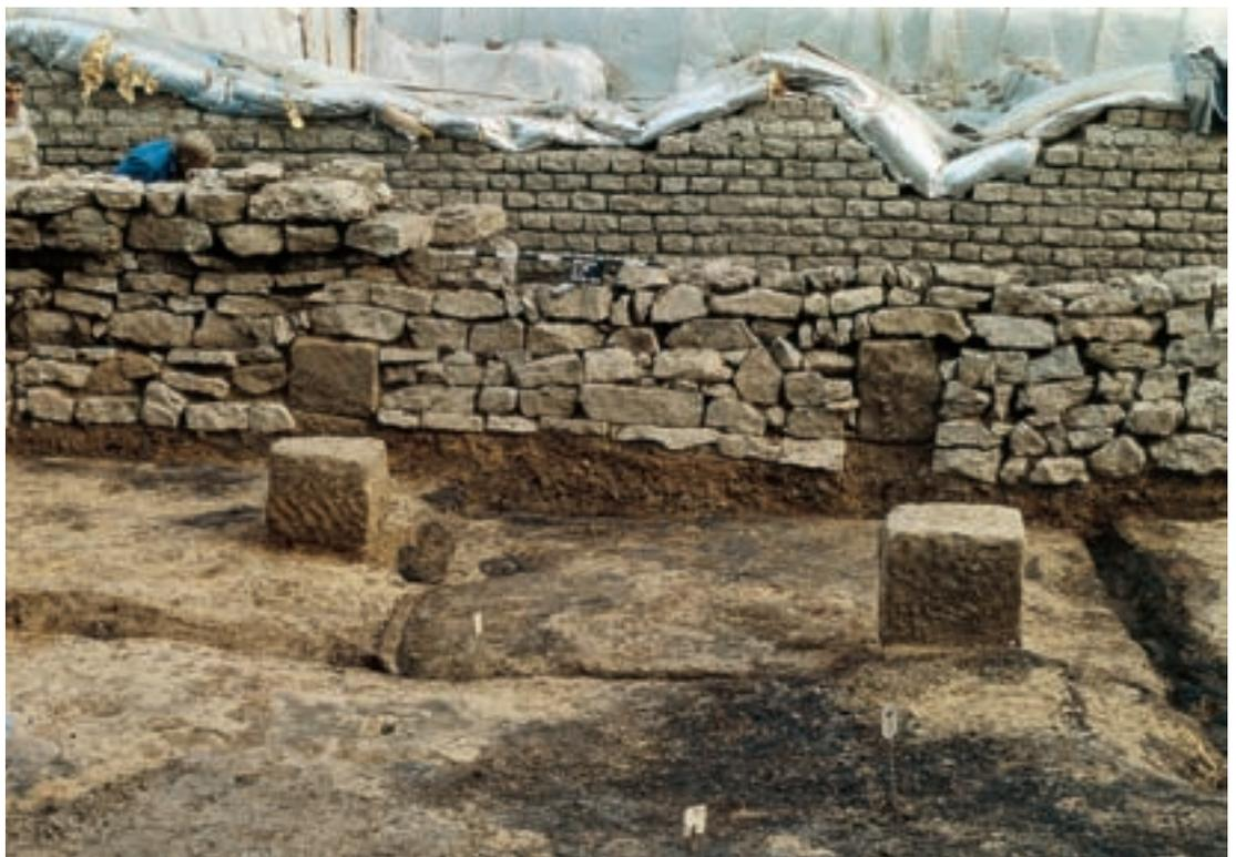
9 Walheim. Römisches Gebäude, dessen tragende Fundamente wie in Güglingen aus Trockenmauerwerk bestehen, in das Stützen aus Sandsteinquadern eingezogen sind.
