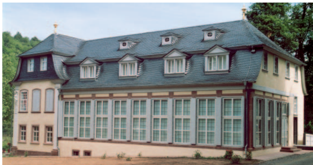
1 Das Eichelhofschlösschen nach der Restaurierung im Juni 2006 von der Saalseite.
