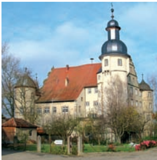
5 Die im 17. Jahrhundert zum Schloss umgebaute alte Wasserburg Waldmannshofen, Zustand 2003.
