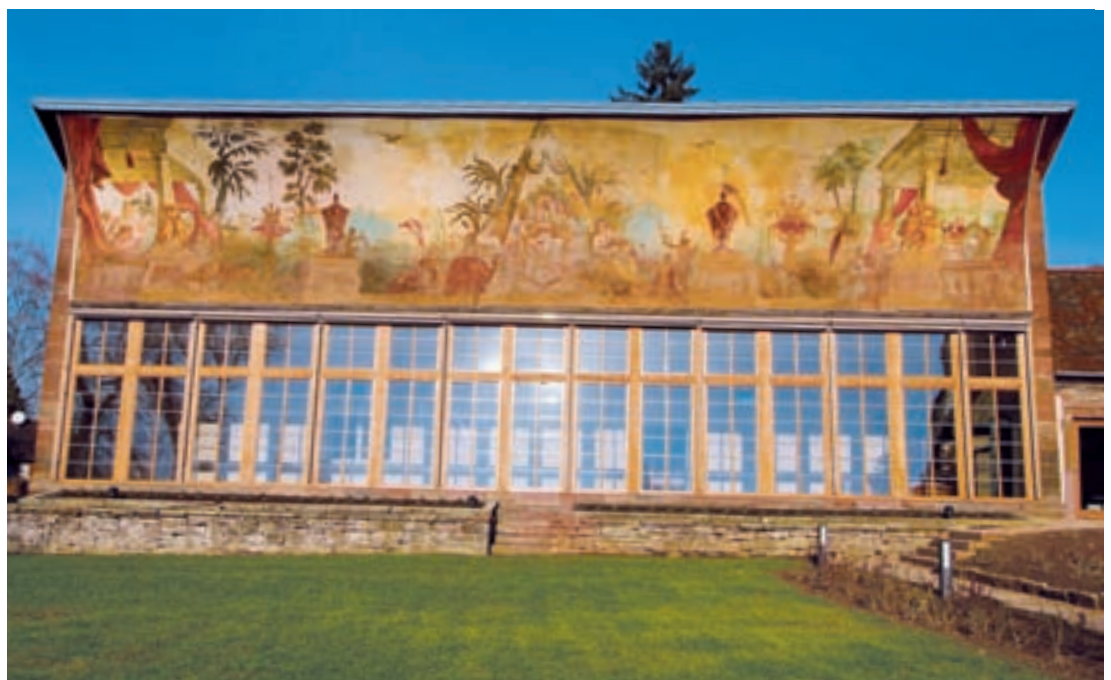
7 Orangerie in Bronnbach von der Schauseite, Zustand nach der Instandsetzung im April 2006.
