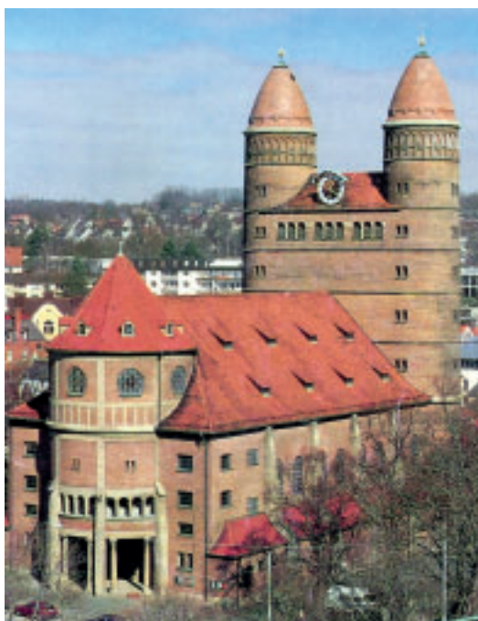
1 Außenansicht der Pauluskirche von Südwesten.
