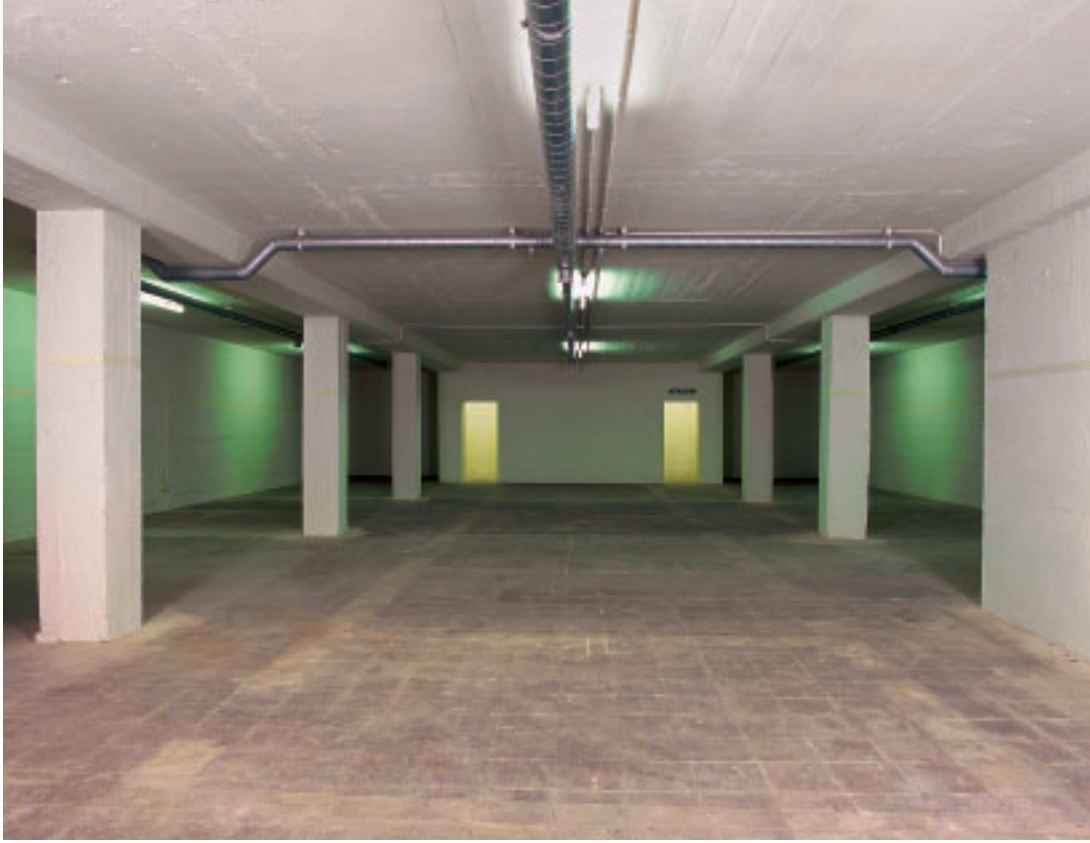
16 Spurensuche: Nach Abbruch der Zellenwände und der technischen Ausstattung von 1941, Bunker Speckweg.
