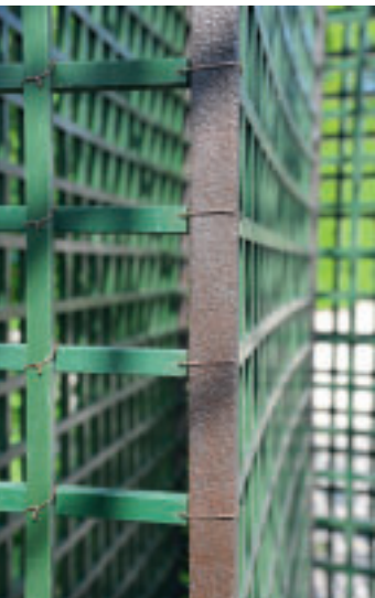
7 Detail der fertig installierten Konstruktion. Grün beschichtet sind die Holzbereiche und die Verdrahtung mit verkupfertem Eisendraht. Die Stützen sind mit einem Korrosionsschutzöl beschichtet.
