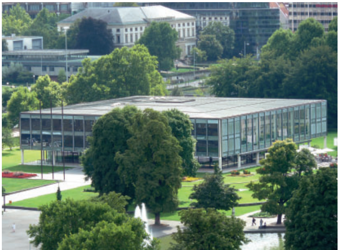
2 Blick vom Bahnhofs-turm auf das Landtagsgebäude.
