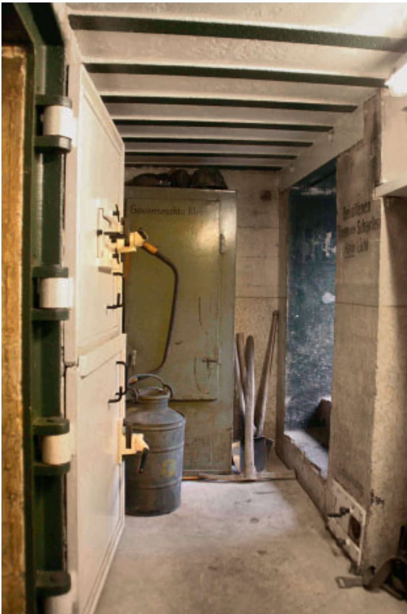
3 Gasschleuse des Museumsbunkers in Bietigheim-Bissingen.
