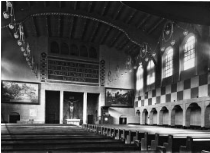
2 Innenansicht der Pauluskirche nach 1910 mit bauzeitlichem Raumkonzept (vor 1970).
