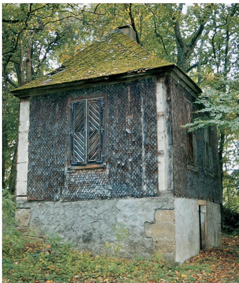
1 Belvedere in Donaueschingen, Friedrich-Ebert-Straße 28a, Außenansicht von Südosten.
