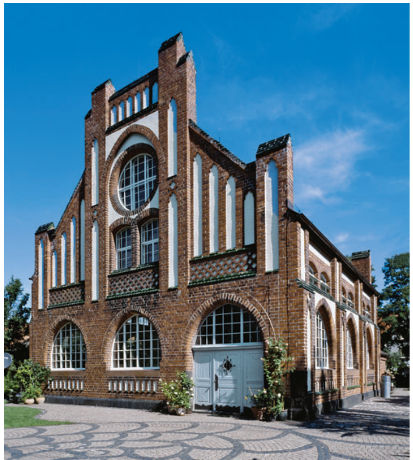
13 Pumpwerk in Mannheim, nach der Restaurierung.
