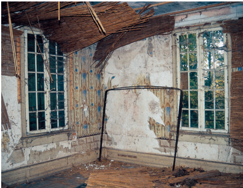
4 Belvedere, Innenraum, Blick in die SO-Ecke.
