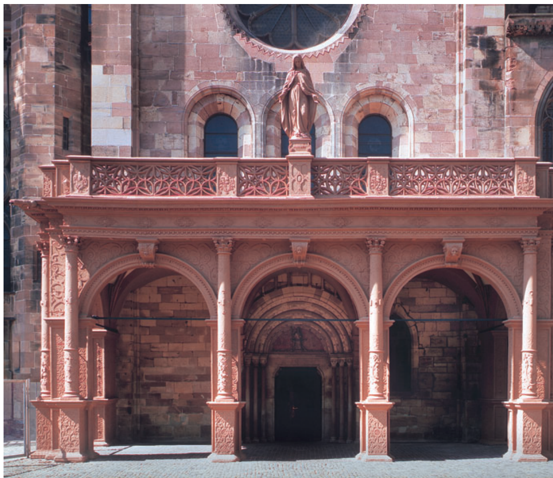
1 Münster Unserer Lieben Frau in Freiburg. Südliche Renaissancevorhalle, Zustand nach Restaurierung, 2004.
