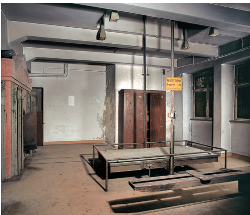
11 Ofenraum im Untergeschoss, Sargaufzug, Dezember 2004.
