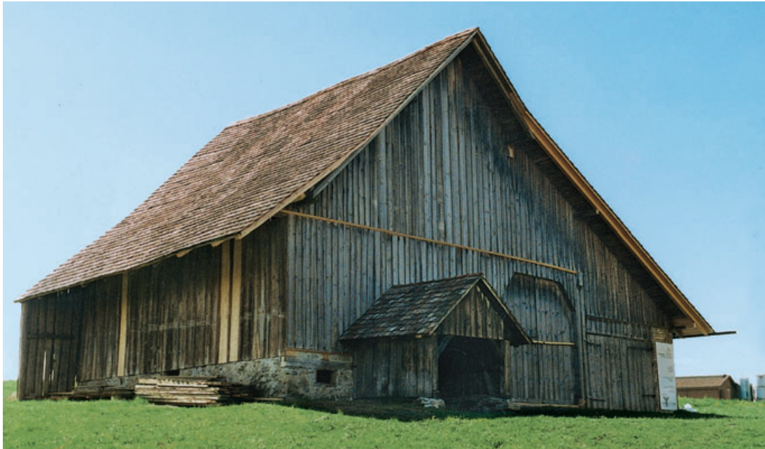
5 Das freistehende Scheuergebäude nach Abschluss der Instandsetzungsarbeiten 2003/2004.
