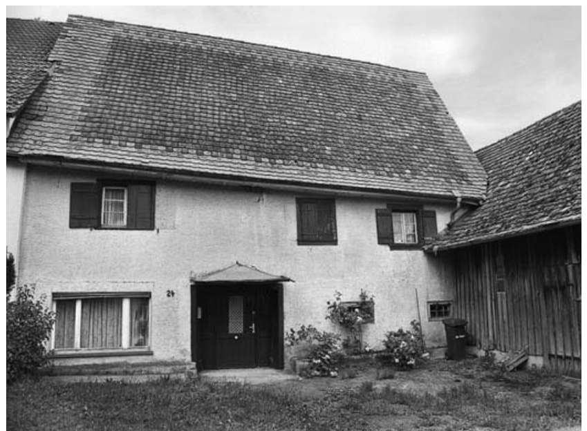
14 Haus in Mittelzell. Das Fenster im Erdgeschoss ist eine Veränderung der Nachkriegszeit am insgesamt authentisch überlieferten Gebäude.
