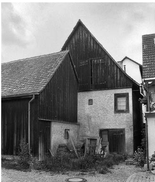
13 Haus in Mittelzell. Der Fischerschuppen verdeckt das spätmittelalterlich Eckfenster. Zu sehen sind das große Tor zum abgetieften Erdgeschosskeller und die Ladeluke im Giebel.
