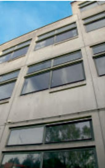
2 Progymnasium Furtwangen. Fassadendetail der im Betonwerk hergestellten Betonelemente mit Metallfensterrahmen und Belüftungsvorrichtungen.
