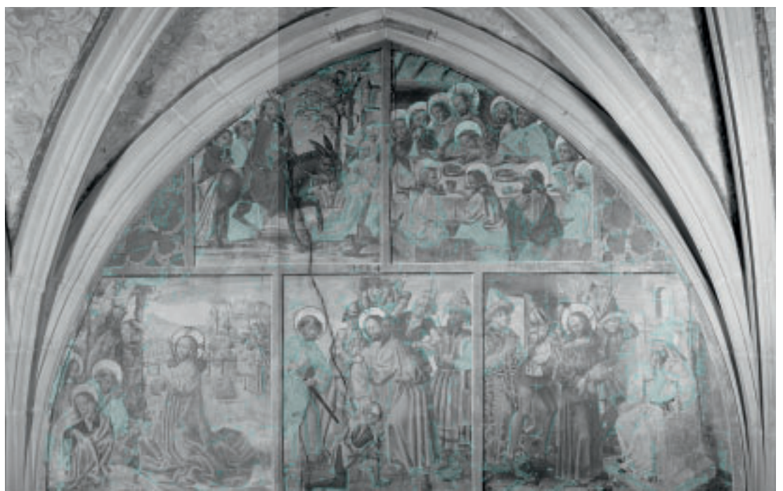
11 Kartierung der Retuschen der Restaurierung 1963 bis 1965.
