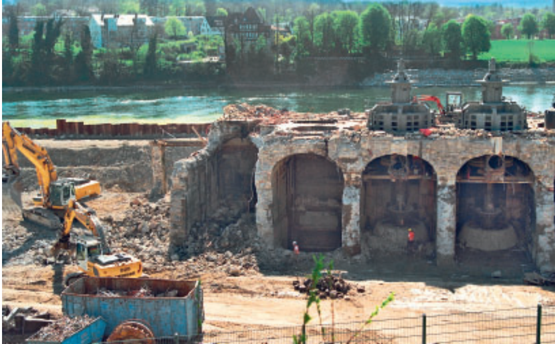
2 Stand der Abrissarbeiten im April 2011.
