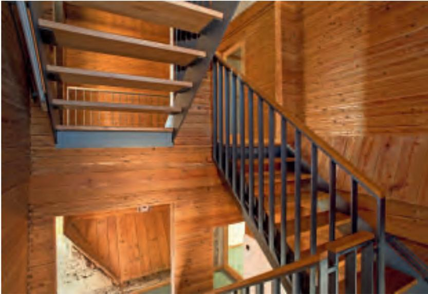
7 Das neue Treppenhaus im Siloschacht mit Brettstapelwänden, aufgenommen vom Podest im zweiten Obergeschoss mit Blickrichtung nach Norden.
