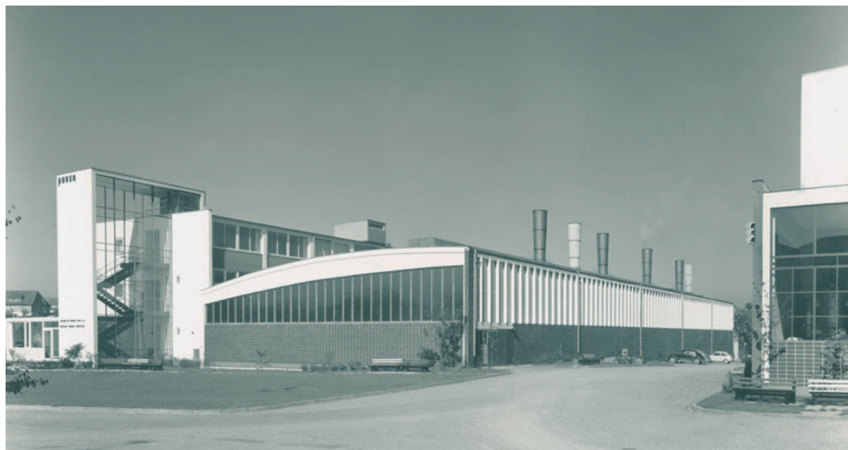
3 Halle für Ausrüstung und Veredelung, Aufnahme vor 1960.
