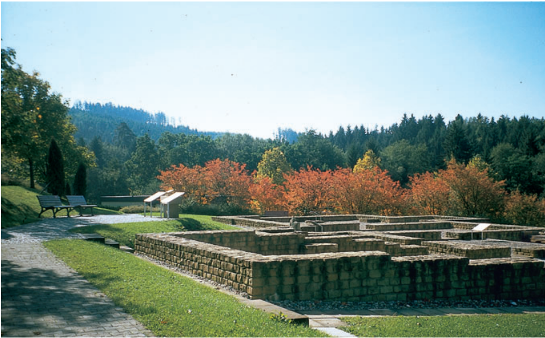
8a Schwäbisch Gmünd. Durch Abdeckung und Nachbau der römischen Mauerzüge am Kastellbad Schirenhof ist die originale Denkmalsubstanz nahezu perfekt geschützt.
