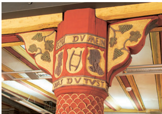
8 Detail der restaurierten Holzstütze im Bürgersaal mit dem eingangszitierten Spruch.
