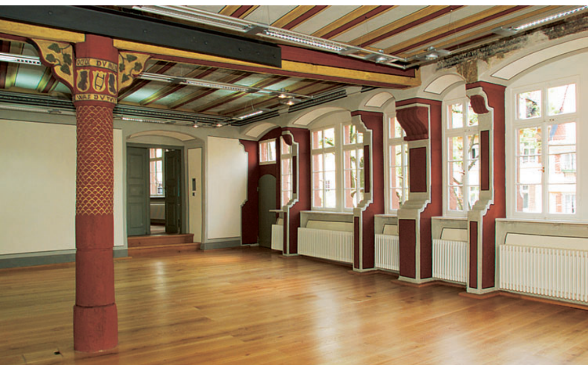
7 Bürgeraal im Mai 2002 nach Abschluss der Sanierung.
