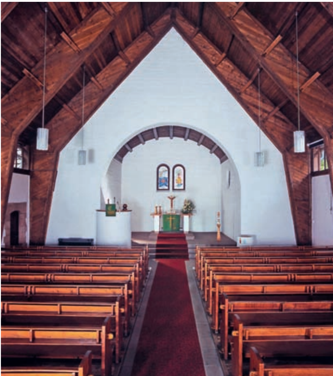
13 Die Gnadenkirche in Mannheim errichtete man als Typ B ohne gesonderten Altarraum. Bereits zur Bauzeit sah man die Wandflächen vermutlich mit einer Schlämme. Markantes Charakteristikum dieser Notkirche ist der individuelle Apsisanbau. Zustand 2005.
