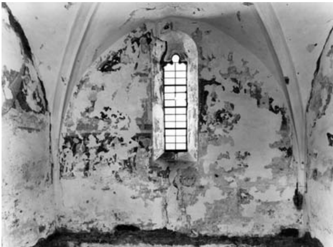
8 Ostwand, Zustand nach Abnahme loser Übertünchungsschichten.
