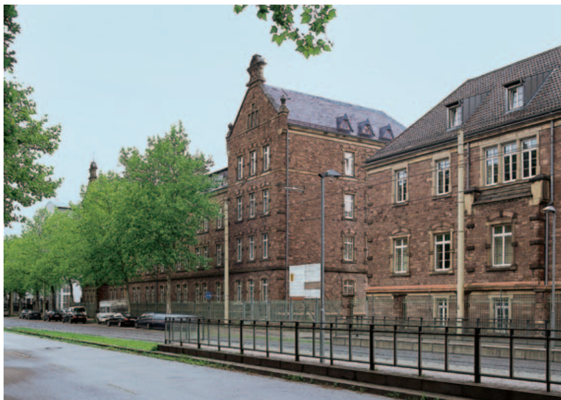
1 Die frühere Grenadierkaserne in Karlsruhe, neuer Sitz des Landesdenkmalamtes. Ansicht von der Blücherstraße, früher Franz-Lust-Straße.
