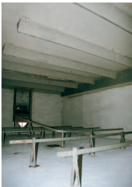
13 Erdgeschossflur mit begonnener Deckenabhängung.
