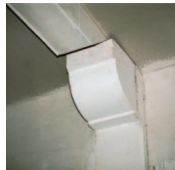
12 Konsolstein mit zur Deckenverstärkung eingehängtem Unterzug, verkleidet wegen Brandschutz.
