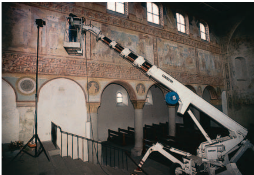
5 St. Georg. Hebebühne für die Schadensuntersuchung durch das Landesdenkmalamt, 1994.
