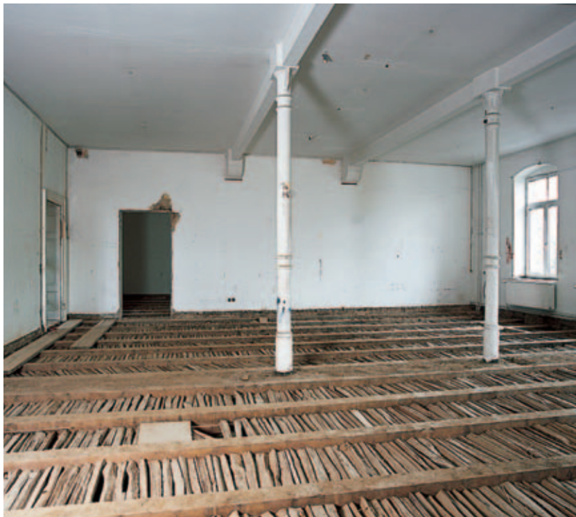
11 Zur statisch notwendigen Verstärkung geöffnete Holzdecken im künftigen Bibliotheksaal mit historischen Eisenstützen.
