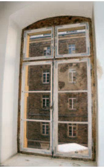
10 Bauzeitliches Fenster, um 1897.
