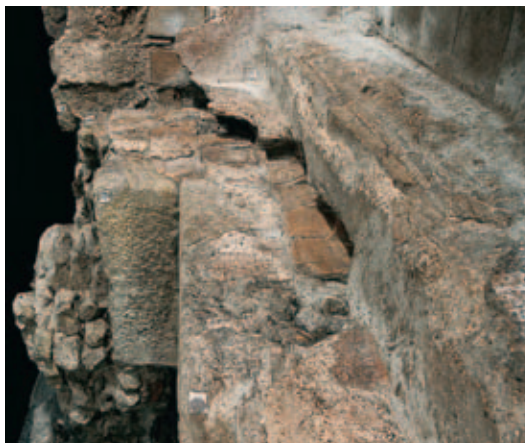
16 Hinterheizte Sitzbank am Einstieg in den alveus im caldarium (C).
