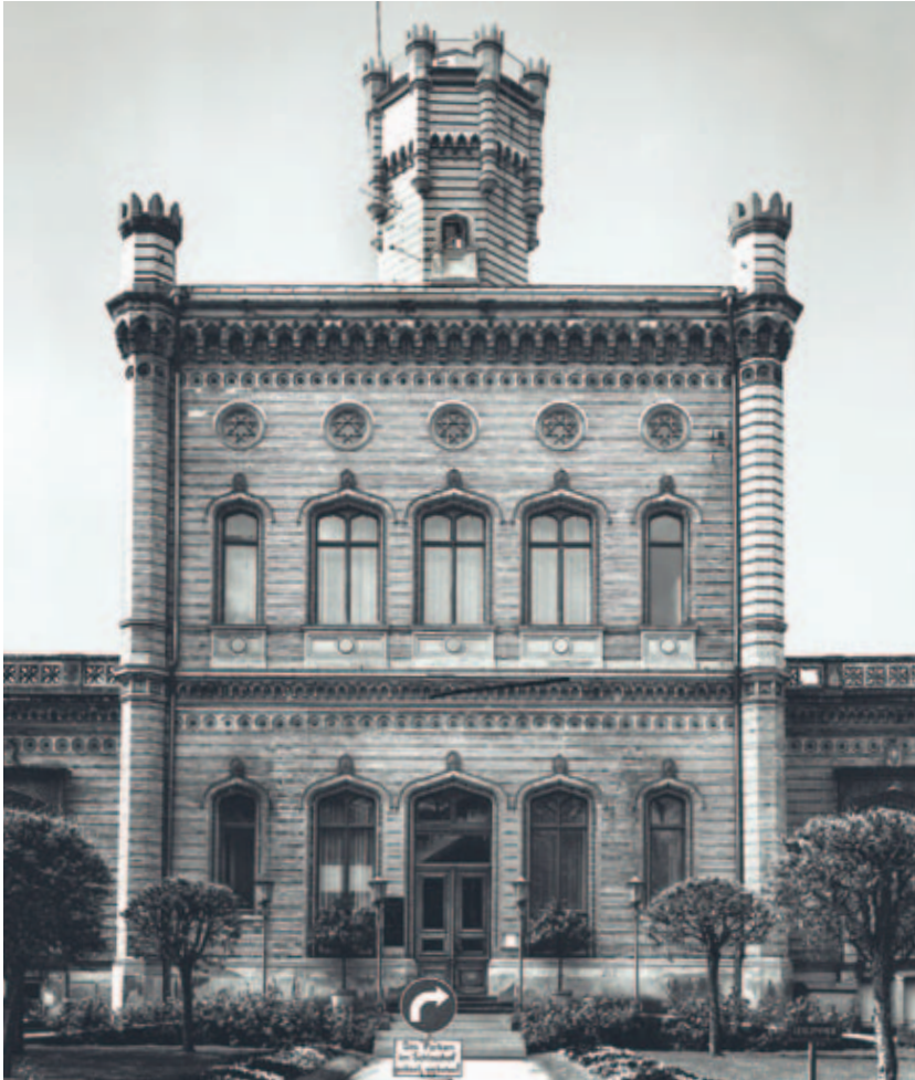
2 Schloss Montfort in Langenargen am Bodensee. Nordostfassade mit Haupteingang 1972. Bauzeitliche Fenster mit dunklem (rotem) Anstrich.
