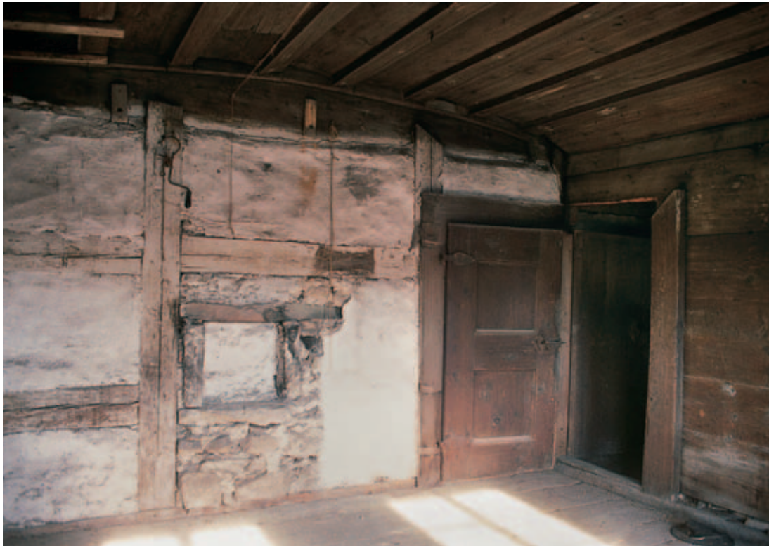
9 Bohlenstube im Dachgeschoss. Ansicht der rückwärtigen Wand mit der Wärmeöffnung, hinter der sich die Heizkammer befand.
