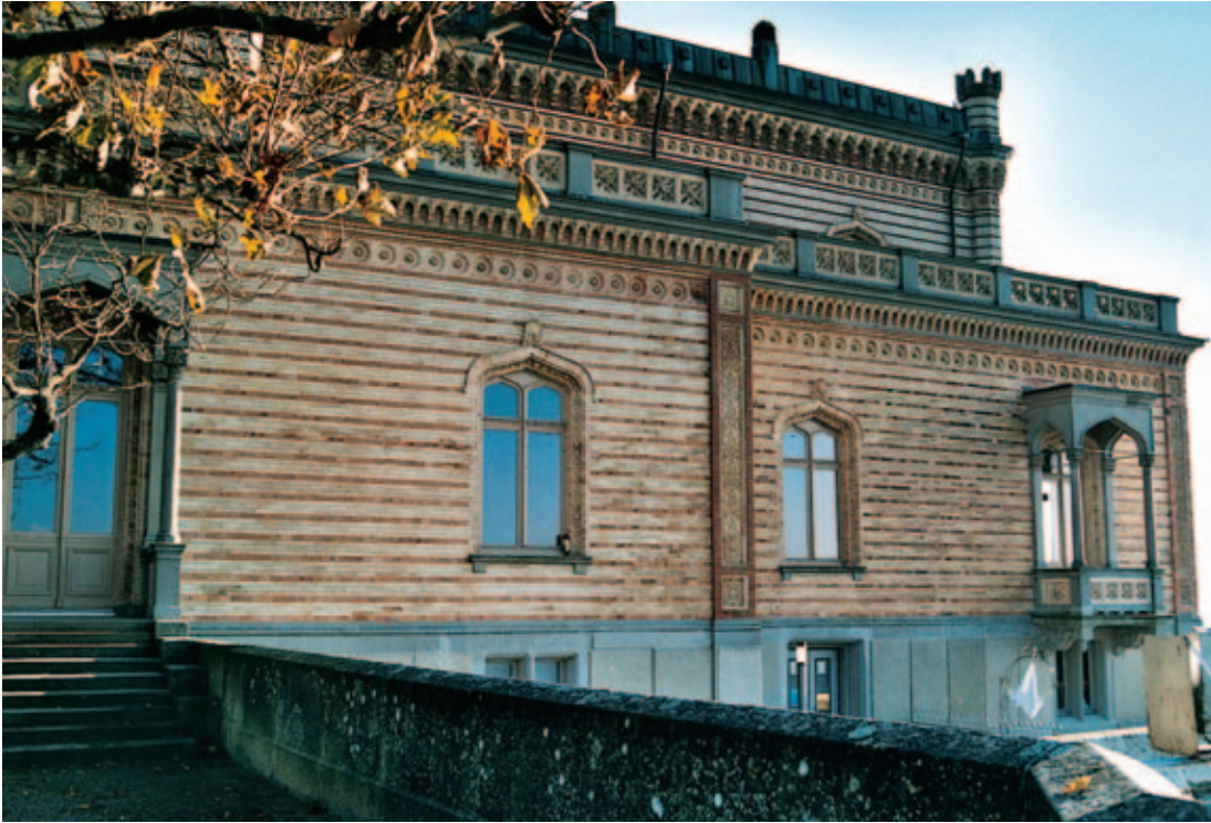
11 Schloss Montfort, restaurierte Nordwest- fassade, 2003.
