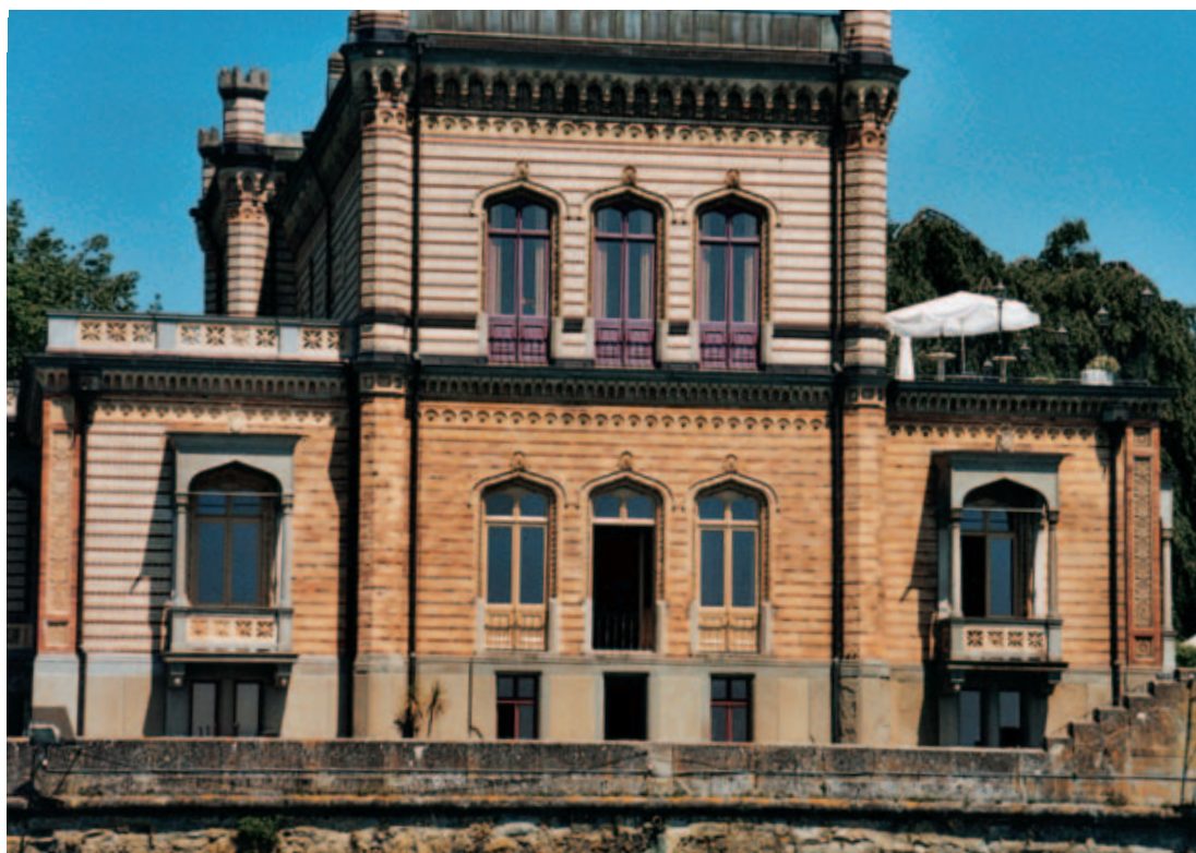
1 Seeseitige Schlossfassade 2001. Im Obergeschoss die um 1975 erneuerten Fenstertüren mit ausgebleichtem dunkelrotem Anstrich. Die vor 1972 erneuerte Verkleinerung weicht maßlich und farblich stark vom Originalbestand ab; die 2001 erneuerten Fenstertüren im Erdgeschoss mit bauzeitlicher Farbgebung.
