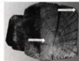
11 Schon früh wurde die Dendrochronologie in der Bauforschung herangezogen – hier: für den berühmten Dachstuhl von Reichenau-Mittelzell (Heft 3/1969).
