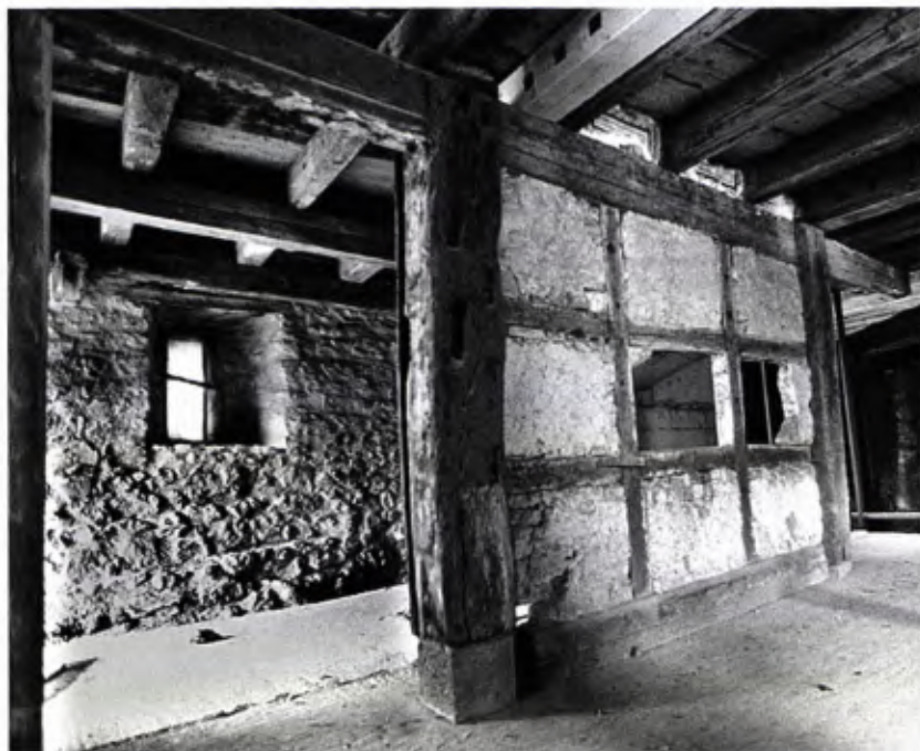
3 Instandsetzungsarbeiten im „Klösterle“, März 1998. Dieser Raum beherbergt heute die „Kneipe“.
