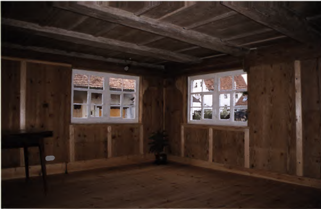
15 Bohlenstube nach der Restaurierung.
