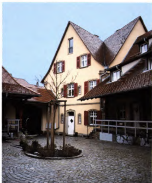
1 Kandern, ehemalige Riegeler Brauereiablage, Ansicht von der Bahnhofstraße.
