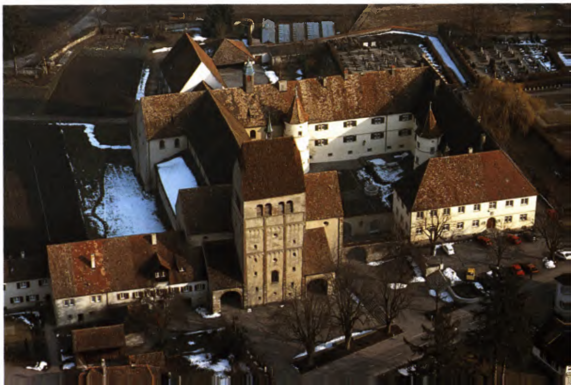
7 Mittelzell, Münster St. Maria und Markus. Links (nördlich) der Kirche in den Gärten der Bereich des älteren karolingischen Klosters, südlich die Klostergebäude des 16. Jhs.
