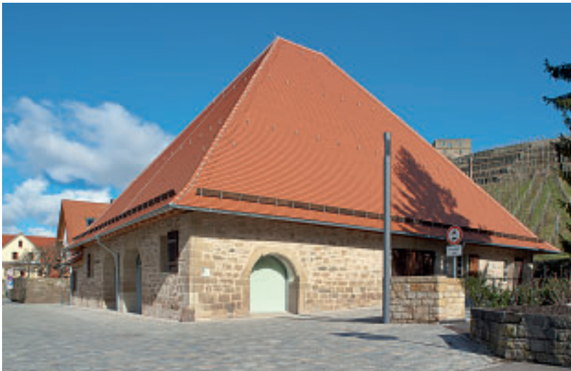
2 Verknüpfung von Bauwerk und Landschaft: Schwarzwaldhöfe im Yachtal, Elzach.
