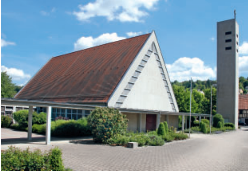
6 Außenansicht der Fertigbaukirche Typ Frank, St. Johannes in Niederstetten. Das Vordach bildet hier eine Verbindung vom Turm über die Kirche bis zu den Gemeinderäumen.
