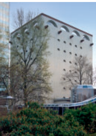
Zu den „unbequemen“ Denkmalen zählen auch Bunker wie dieser so genannte MVV-Bunker im Jungbusch in Mannheim.
