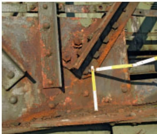
6 In Spaltbereichen, wie hier zwischen zwei vernieteten L-Profilen, kann Feuchtigkeit eindringen und auf Dauer zu Spaltkorrosion führen, die aufgrund der Volumenzunahme der Korrosionsprodukte erhebliche Verformungen verursachen kann.
