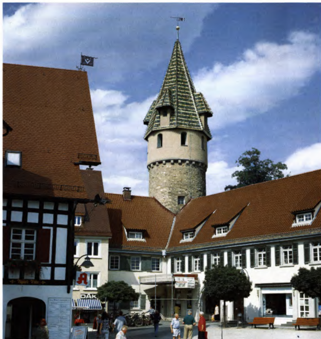
1 Der Grüne Turm in Ravensburg nach Abschluss der Reparatur seiner Dachhaut im Jahr 1998. Blick vom Marktplatz.
