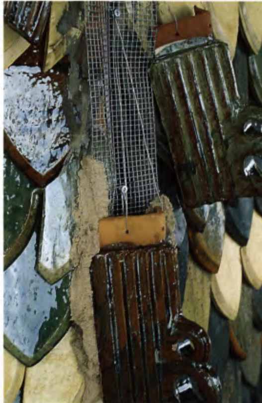
14 Detailaufnahme der Verlegung der Gratziegel.
