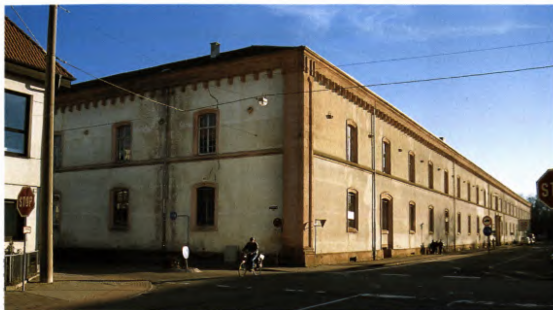
1 Das ehemalige Festungslazarett, das heutige Zentrale Fundarchiv in Rastatt, Ansicht von Norden.
