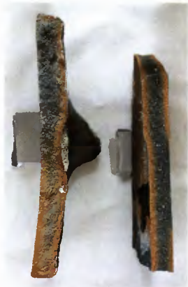
11 Bruchbild eines bauzeitlichen Ziegels mit grauem Reduktionskern.
