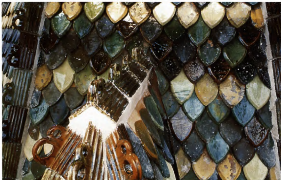
2 Gaubenfirst des Grünen Turms nach der Reparatur.
