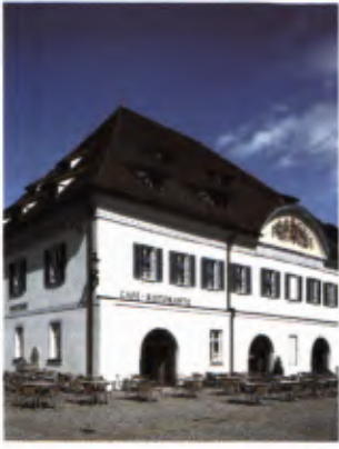
Seeseitige Ansicht der Gred in Überlingen nach der Sanierung 1998.
