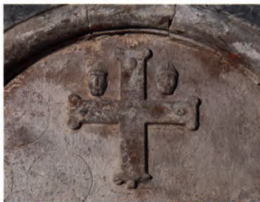
1 Grenzach, Portal und Tympanon nach der Freilegung 1998.
