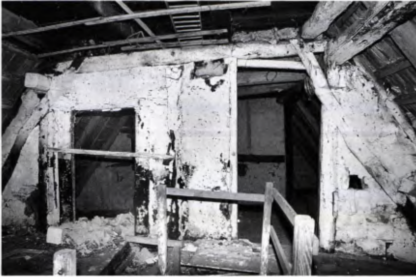
8 Dapfen, Oberdorfstraße 46. Blick durch den Dachraum der mittleren Zone nach Osten auf die Querwand im östlichen inneren Querbund. In der Wandmitte die Firstsäule, oben Kehlbalken, seitlich Gespärre und stehender Stuhl mit Steigbändern, zudem Reste der bauzeitlichen Flechtwerkausfachung.
