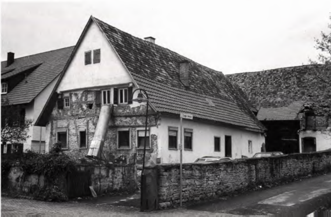
1 Gärtringen, Kirchstraße 20. Gesamtansicht von Südosten. Baukörper und Grundgliederung des Baues werden von der spätmittelalterlichen Hauskonstruktion bestimmt.
