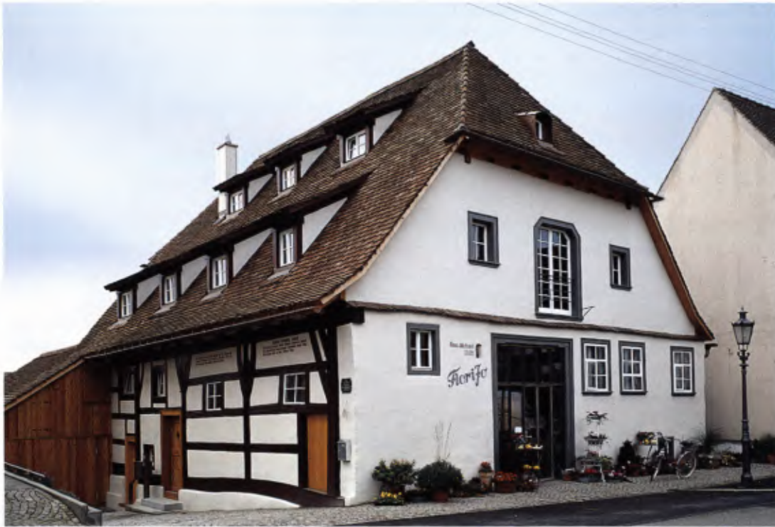
8 Ansicht von der Hauptstraße nach Abschluss der Sanierung im Oktober 2001.
