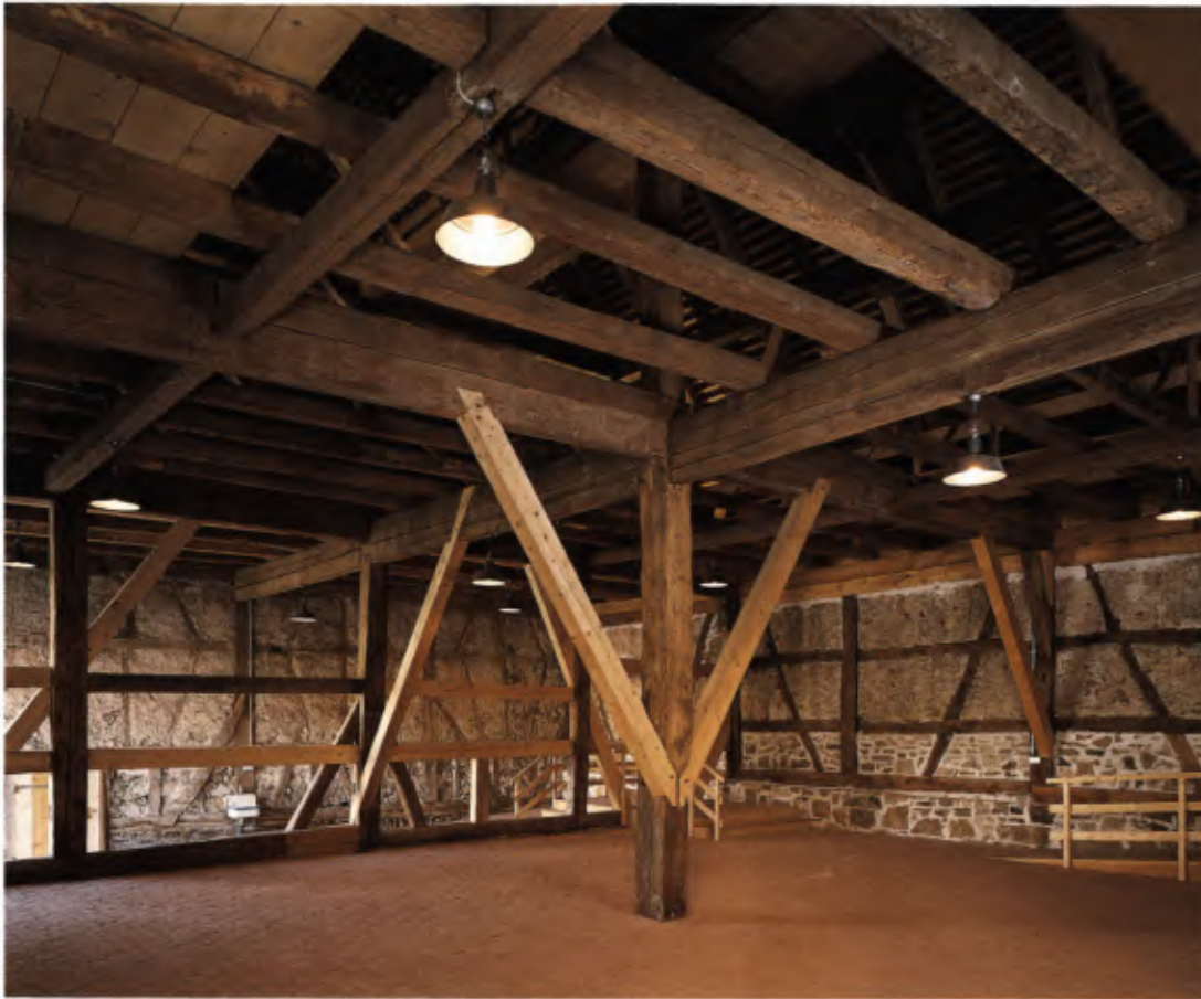
4 Die Zehntscheuer nach ihrer Renovierung mit repariertem Tragwerk und neuem Ziegelbelag.
