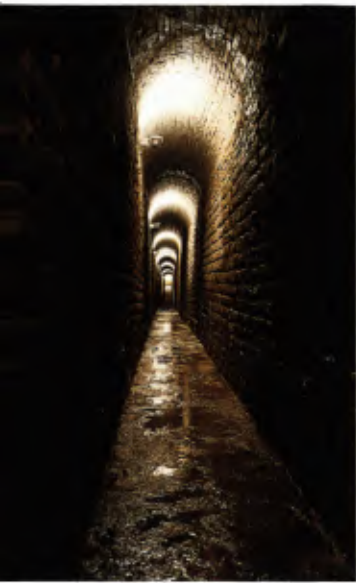
12 Blick in den 1998 wieder hergestellten großen Drainagekanal, der zur Ableitung von Hang- und Abwasser diente und diese Funktion auch heute teilweise wieder übernimmt.
