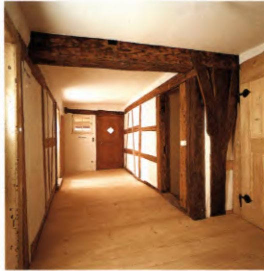
10 Der Freisitz im Dachgeschoss hinter dem offenen Fachwerk mit innenliegender Verglasung. Oktober 2001.
