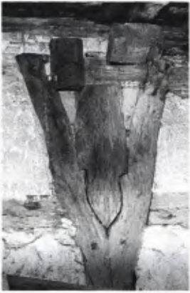
6 Bundständer mit Riegeln und Kopfbändern von 1461 in der östlichen Traufwand. Zustand 1996.
