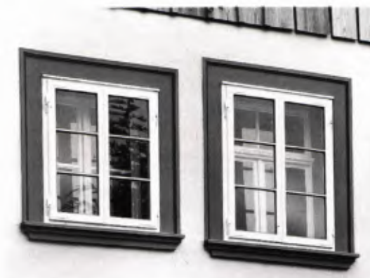
13 Die Fenster des 19. Jahrhunderts im Südgiebel erhielten neue Vorfenster. Oktober 2001.
