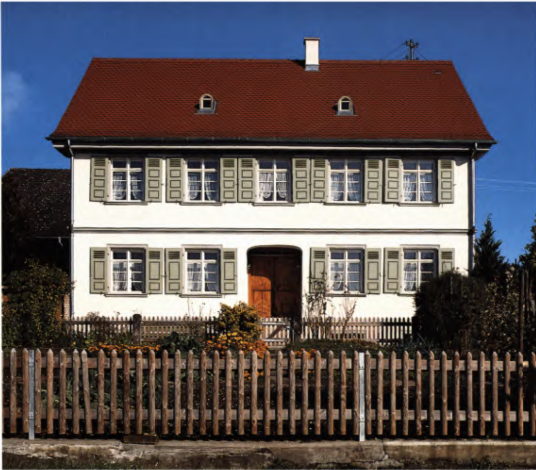
5 Kressbronn, Haus Tettnanger Str. 28, Blick über den Bauerngarten auf die restaurierte Südfassade. Vier verlorene Fenster im Erdgeschoss konnten durch nahezu baugleiche Altfenster ersetzt werden. Zustand Oktober 2001.
