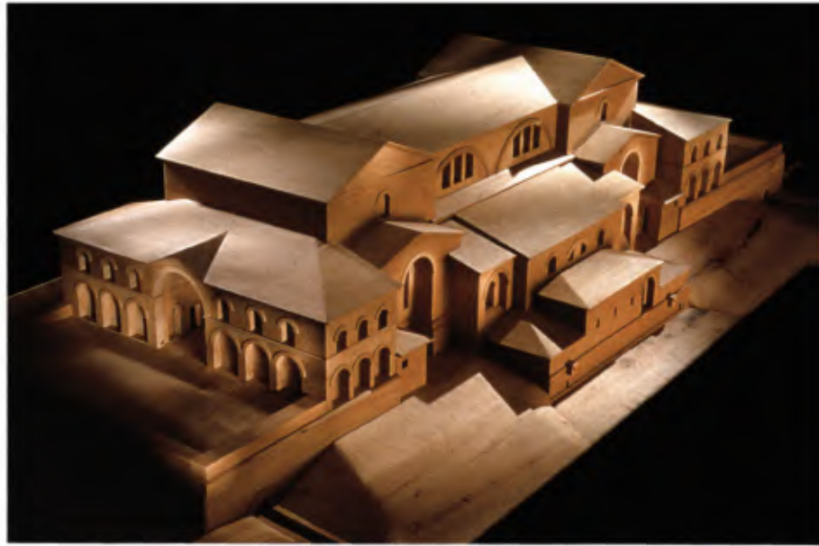
14 Holzmodell der römischen Heilthermen von Badenweiler, späterer Bauzustand. Blick von Nordosten. Modellmaßstab 1:66,6.
