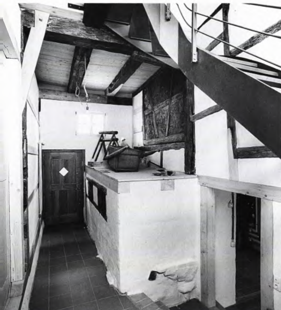
12 Das neue, zentrale Treppenhaus mit Blick auf den östlichen Haus- eingang und den ehemaligen Ziegenstall. Oktober 2001.
