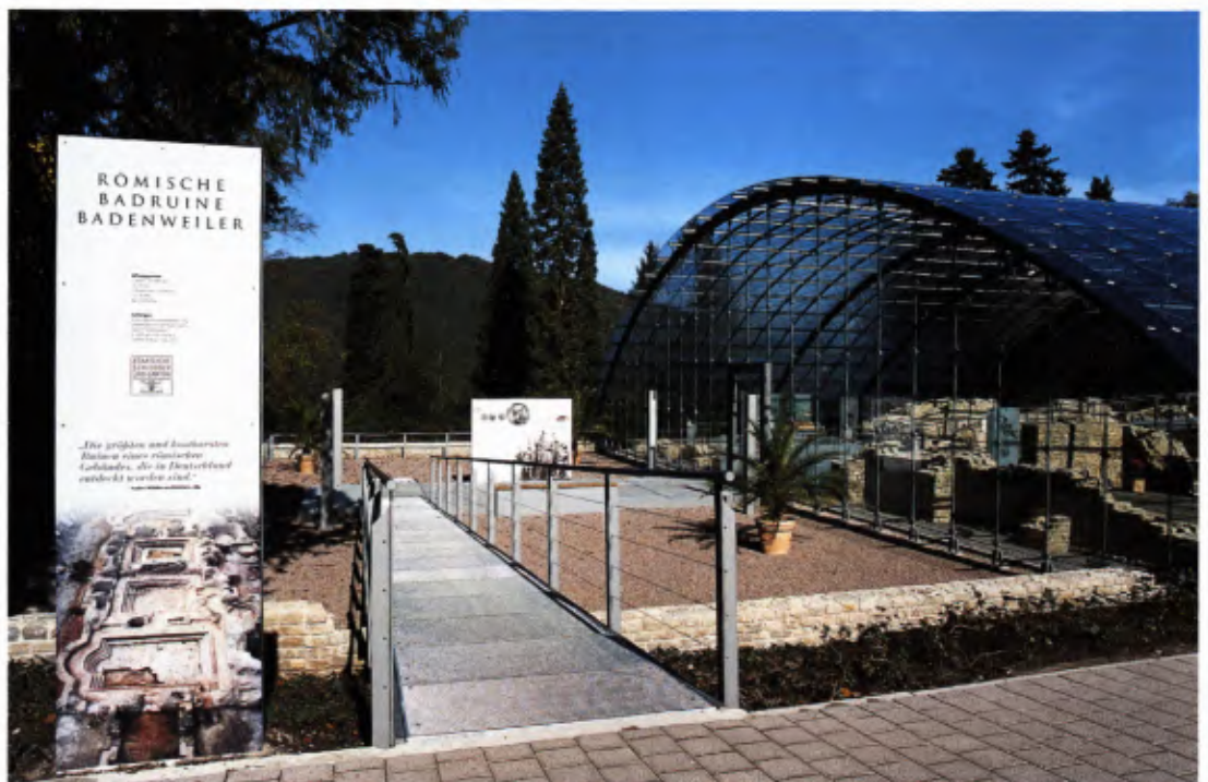
17 Eingang in den neuen Schutzbau der römischen Badruine von Badenweiler.
