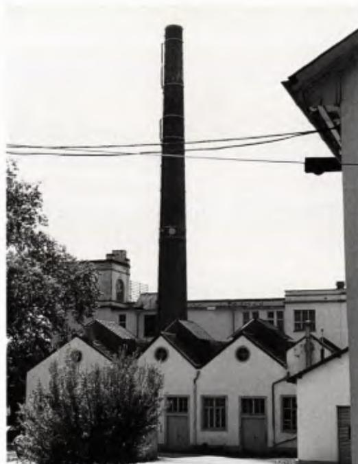
4 Das Kesselhaus mit Schornstein, Mitte 19. Jh. besitzt eine leichte Satteldachkonstruktion wegen der Explosionsgefahr.
