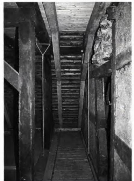
■ 15 Blick in den Dachstuhl zwischen die mittigen Bindergespärre, an die die Obergeschoßdeckenbalken aufgehängt wurden (1996).
