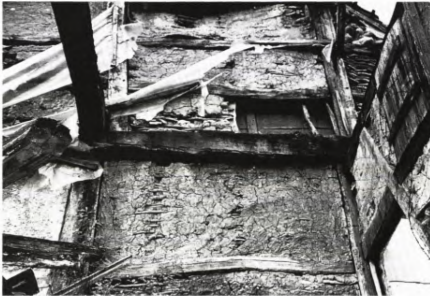
■ 1 Lehmflechtwände in dem Haus Hauptstraße 6, Gailingen, Kreis Konstanz, aus dem 15. Jh.
