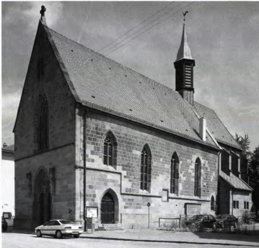
■ 1 Heilbronn, Nikolaikirche. Ansicht von Süden.
