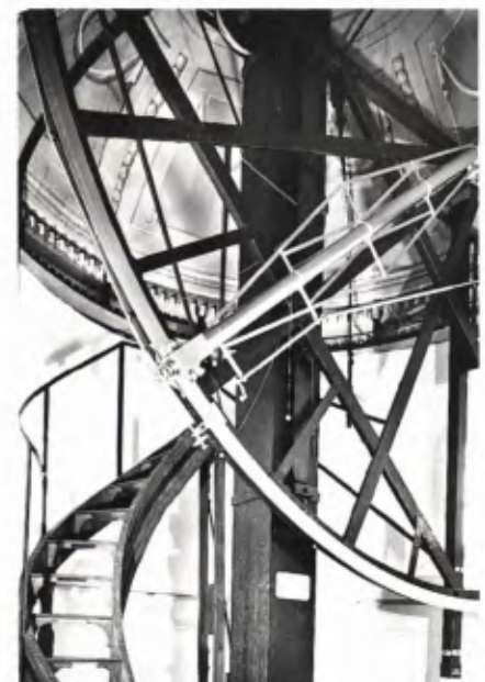
■ 7 Kloster Ochsenhausen, „Observatorium Astronomicum“, Azimutalquadrant. Erst durch dieses 1793 für das Kloster konstruierte Instrument wird die Funktion des Turms als Sternwarte richtig anschaulich. Das Foto zeigt den Zustand 1990 nach der Restaurierung mit ergänztem Fernrohr.
