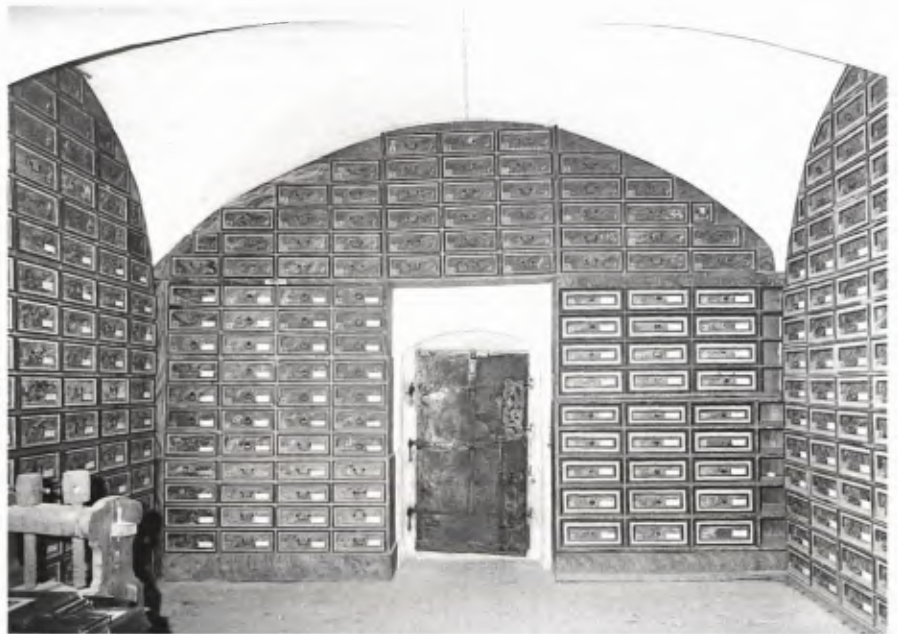
■ 1 Schloß Weikersheim, Archivraum. Das Schubladensystem wurde in der Mitte des 18. Jahrhunderts eingerichtet, nachdem der gewölbte Raum im Erdgeschoß durch vergitterte Fenster und eine massive Eisentür mit Spezialschloß vor unberechtigtem Zutritt gesichert worden war. Foto: Hauptstaatsarchiv Stuttgart.
