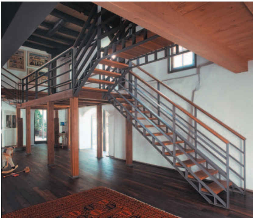
16 Ehemaliger Mahlboden mit neuer Treppenföhrung.
