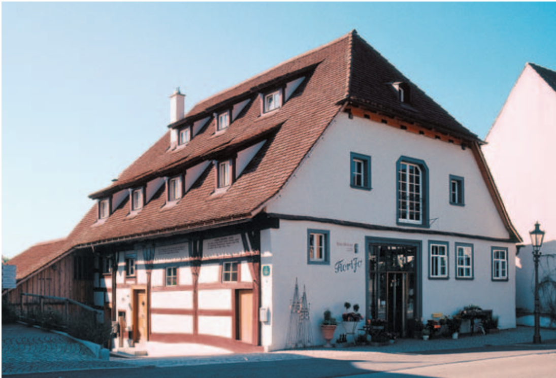
17 Haus Michael in Immenstaad, Straßen- ansicht.
