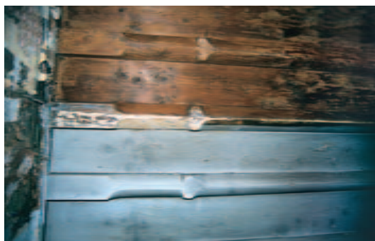
11 Bohlenbalkendecke während der Freilegung.
