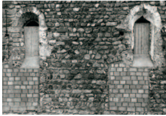
9 Münster St. Peter und Paul in Niederzell. Fenster in der Nordwand des nördlichen Choranraumes: Die romanischen Fenster wieder geöffnet; die barocken zugesetzt. Zustand 1974.
