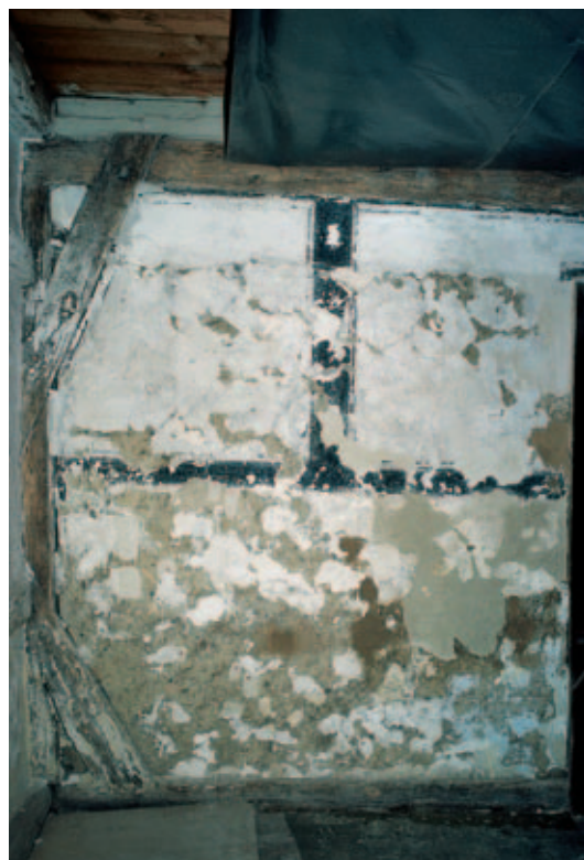
16 Flur, Außenwand der Bohlenstube links der Tür. Lehmwand mit Scheinfachwerk im Vorzustand.
