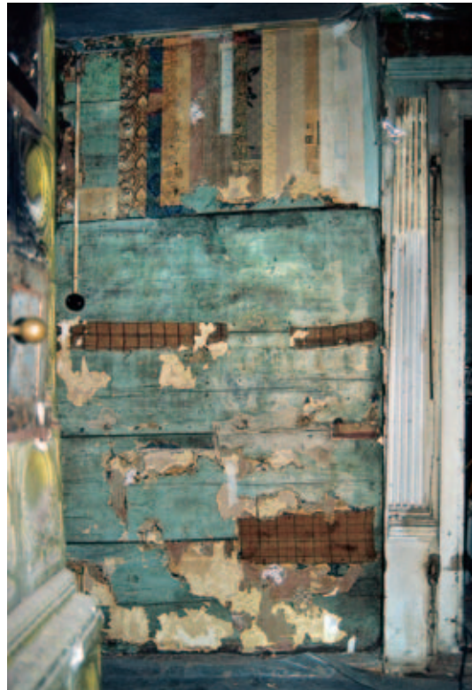
4 Wandbereich links neben der Tür mit Tapetenbeklebungen vor der Freilegung und Sondierung.
