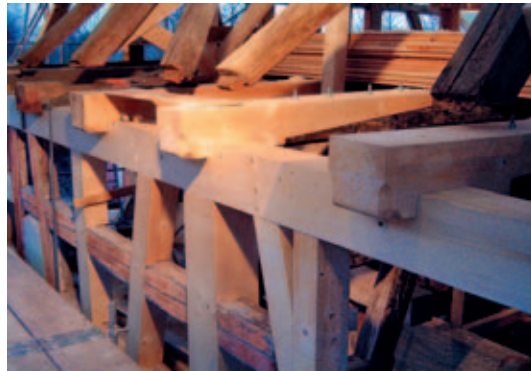
16 Südliche Traufe während der Reparatur, neuer Rähmbalken wird für den Wiedereinbau vorbereitet, Zustand Dezember 2003.
