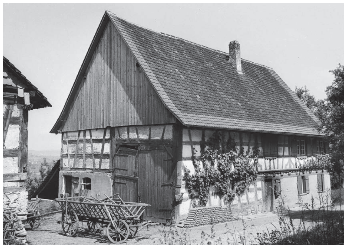
1 Meersburg-Schiggendorf, Schmiede. Blick von Südwesten auf den Ökonomieteil des Hauptgebäudes, Zustand 1957. Foto: Alfons Rettich, Konstanz.
