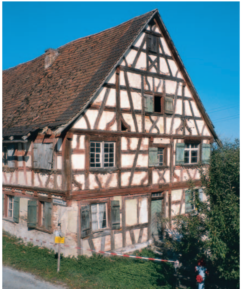
14 Giebel des Wohnteils, Zustand Herbst 2003.
