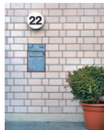
6 Durchgehend unverputzt: Das im Ziegelmaß geplante Mauerwerk verlangte vom Architekten und Maurer höchste Aufmerksamkeit.
