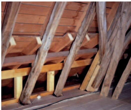
18 Nordseite im Bereich der Dacherweiterung von 1963/64 nach den Reparatur- und Sicherungsmaßnahmen von 2003. Die Schubkräfte des Pultdaches werden durch einen neu eingebauten Kniestock nicht mehr auf die Sparren des Hauptdaches, sondern senkrecht abgetragen.
