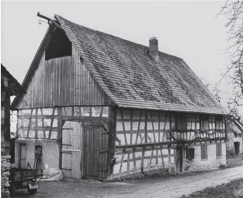
8 Giebel des Ökonomieteils nach Einbau des Heuaufzugs, Zustand 1973.
