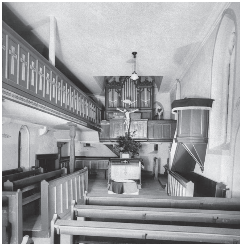
4 Innenaufnahme nach Osten vor dem Umbau 1963/64 mit Längsempore an der Nordwand und Orgelempore im Osten. Die Orgel von 1870/71 ragte in den Dachraum hinein.
