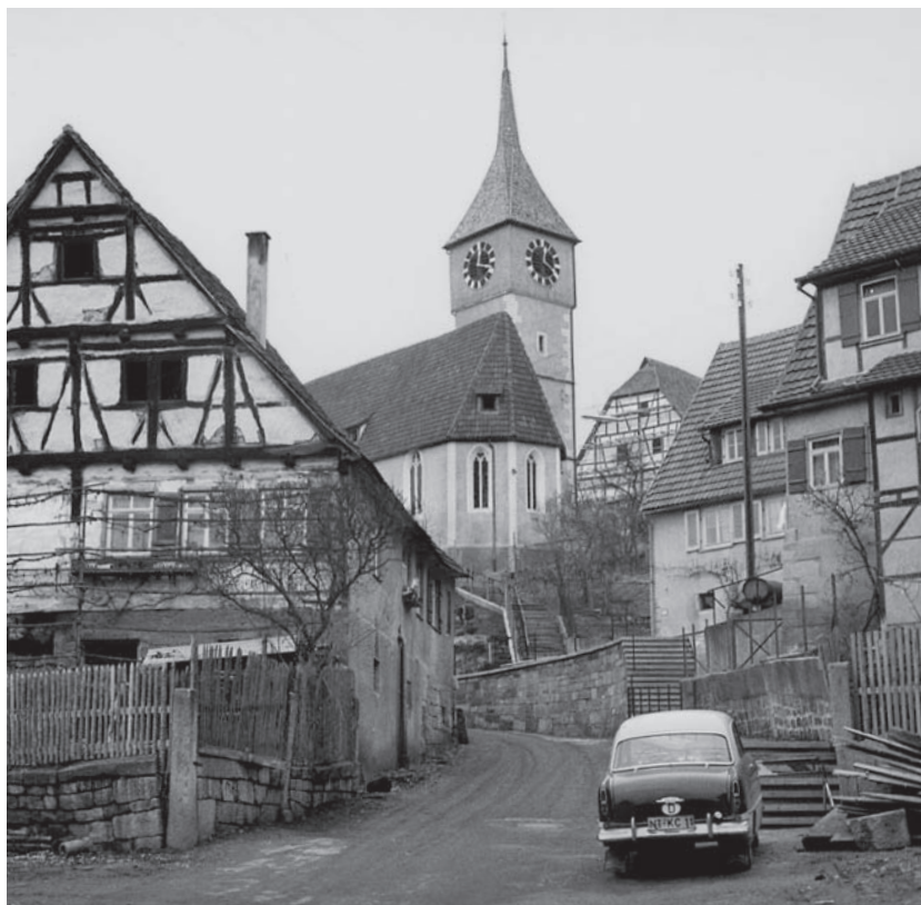
2 Blick auf die Kirche mit Treppenaufgang von Südosten um 1960.
