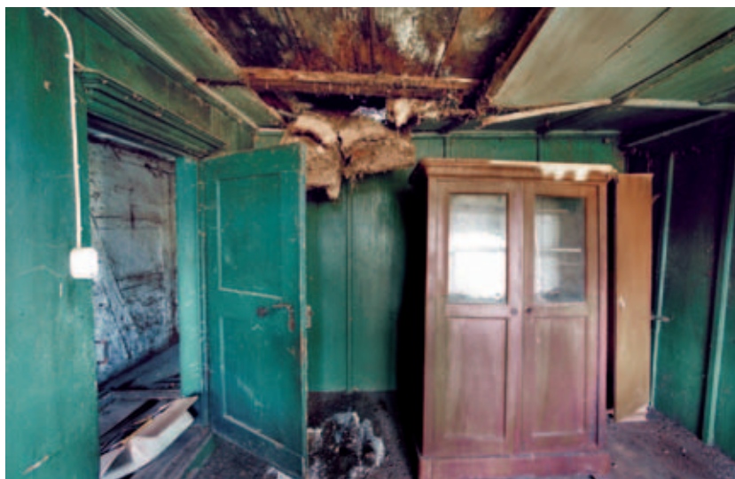
3 Nordöstliche Stube im Obergeschoss mit teilweise heruntergebrochenem Deckentäfer, Zustand Oktober 2003.
