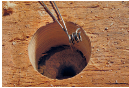
13 Edelstahlspirale beim Einsetzen in die Bohrungen.
