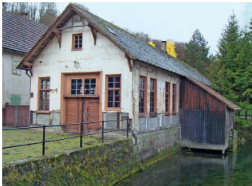
1 Außenansicht der Feilenschleiferei vor der Sanierung 2001.
