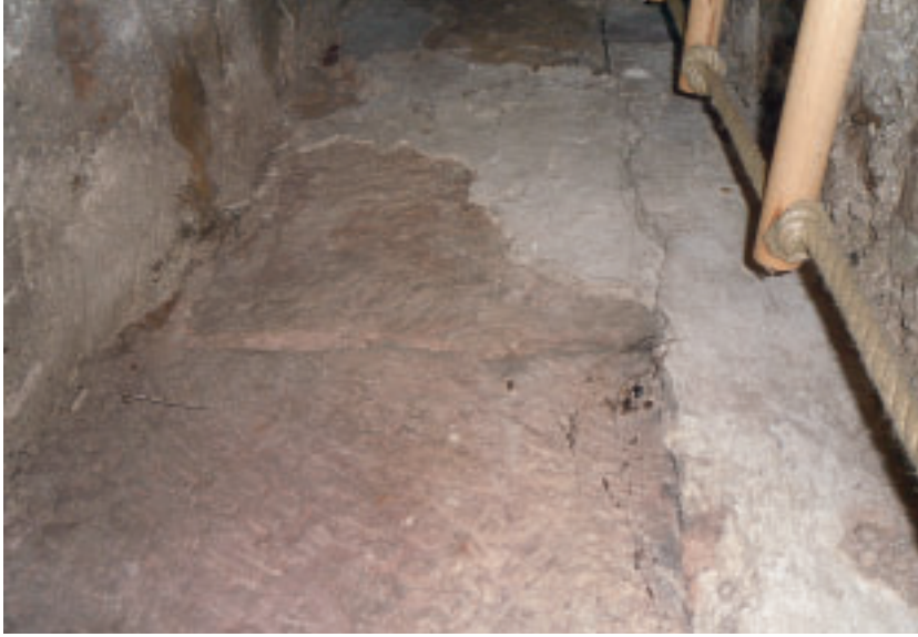
12 „Hohler“ Strebe- pfeiler an der Südostecke des Kapitelsaals, Blick auf die Baufuge zwischen spätgotischem Polygon- schluss (rechts) und hoch- mittelalterlichem Kalk- quadermauerwerk (links).
