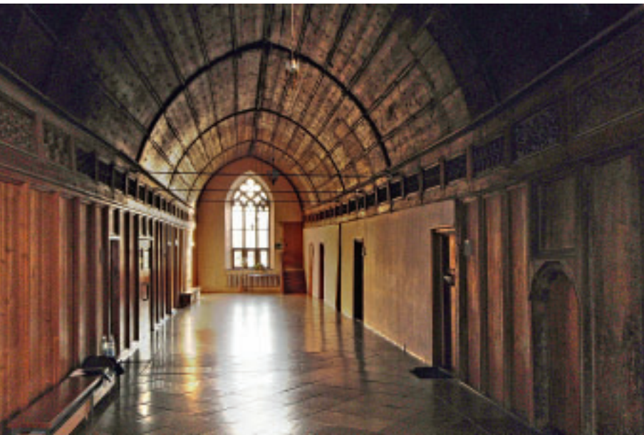
3 Mittelgang des Dorments im ersten Obergeschoss mit der in das Dachwerk einschneidenden hölzernen Spitztonne. Blick im Querflügel nach Osten.
