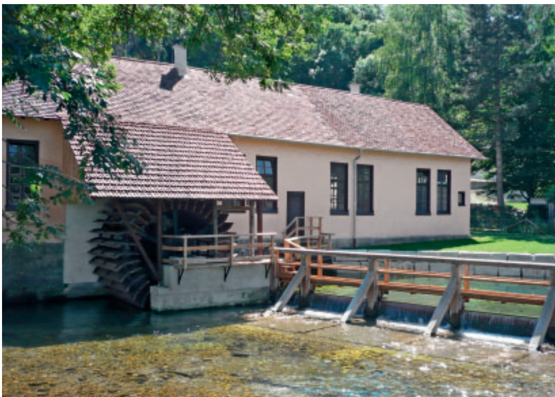
5 Ansicht der Fabrikmühle nach der Sanierung mit Streifenwehr und Mühlrad, 2011.
