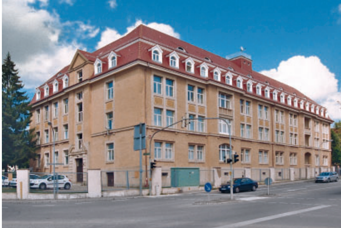
11 Kaserne Donaueschingen, Mannschaftsgebäude, Straßenfassade.
