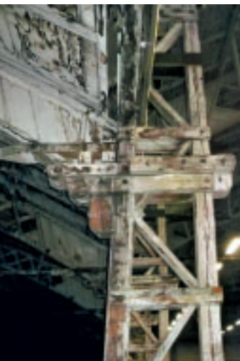
4 Halle 15 und 16, Hauptstütze, Detail (2013).
