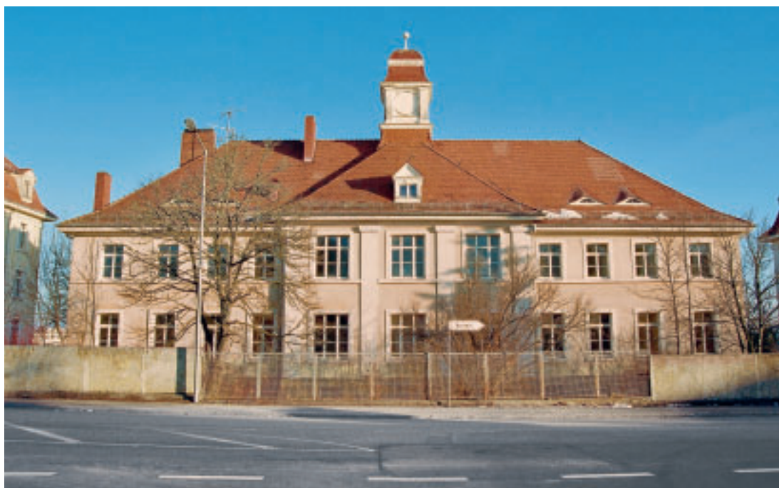
1 Kaserne Villingen, Wirtschaftsgebäude, Straßenfassade.
