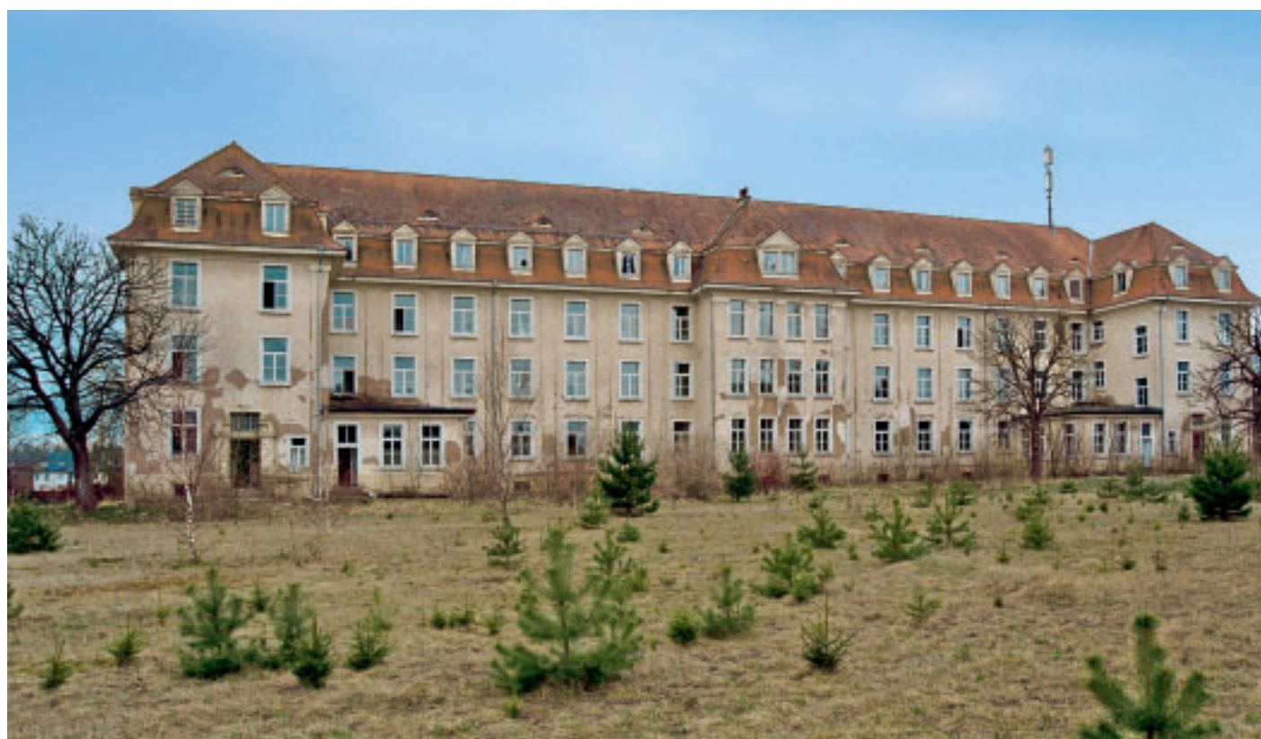
5 Kaserne Villingen, Mannschaftsgebäude, Fassade zum Exerzierplatz.
