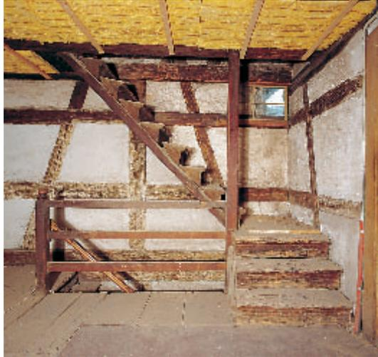
bestand verbunden werden. Verformungen konnten teilweise rückgängig gemacht werden. Entstellende Beihölzer wurden entfernt, und die ursprüngliche Tragwerkswirkung der doppelt liegenden Dachstühle wurde wiederhergestellt. Zusammen mit dem zurückhaltend eingebrachten, zeitgemäßen Wohnkomfort sind zwei aus wenigen, großen Räumen gebildete Altstadtwohnungen mit eindrucksvoller Atmosphäre entstanden bzw. erhalten geblieben. Die geräumigen Zimmer haben indessen den Vorzug, die
