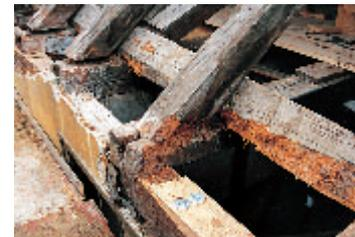
11 Westliche Traufe während der Reparatur: schadhafte Mauerlatte ist bereits ausgetauscht; Vorholz der Zapflöcher ausgebrochen; Fäulnis-schäden an Balkenkopf und Stuhlschwelle, Zapf-verbindingen haben sich gelöst. Zustand 1999.
