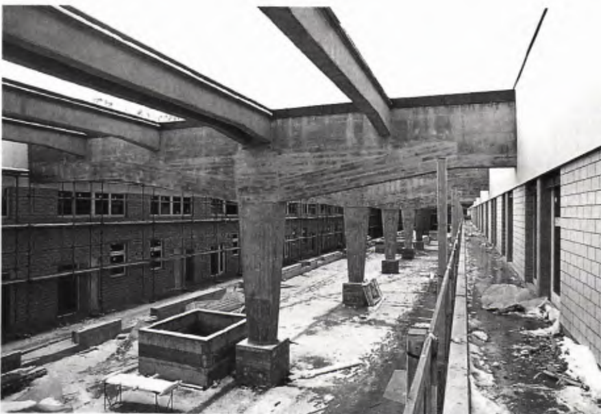
■ 2 Umnutzung einer ehemaligen Spinnerei in Oberuster zu Wohnungen.
