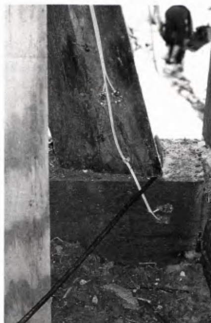
■ 4 Holzfeuchtemessung während der Sanierung des Gebäudes in Groß Lengden.
