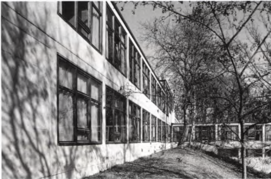
■ 4 Blick auf die Hauptfassade.
