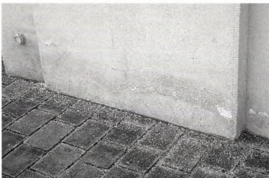
■ 15 Anwendung des Mauersägeverfahrens mit einer wassergekühlten Seilsäge. Im Bild ist eine Umlenkrolle mit Seil zu sehen.
