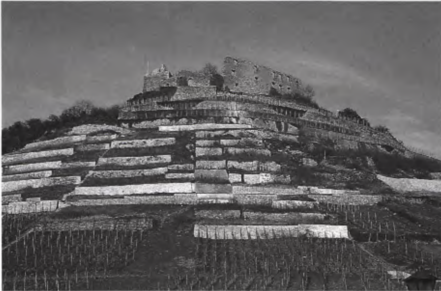
■ 7 Der Schloßberg nach Abschluß der Mauerinstandsetzung.
