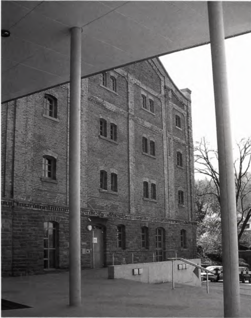
■ 2 Mosbach, Alte Mälzerei. Detail der Westfassade.
