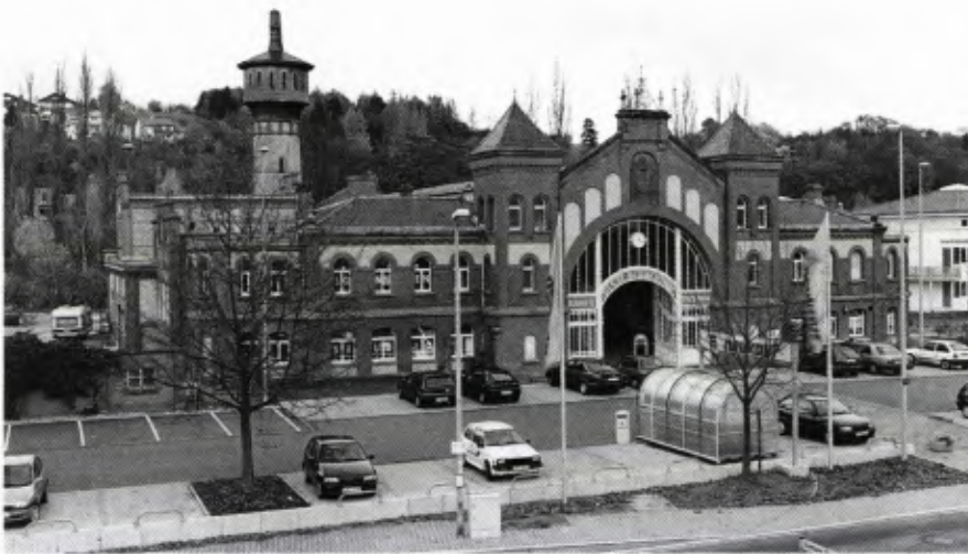
■ 1 Bruchsal, Schlachthof. Ansicht von Süden, 1997.
