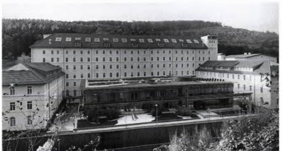
■ 7 Ansicht des sanierten Gründungsbaues mit der neuen Halle im ehemaligen Fabrikhof.
