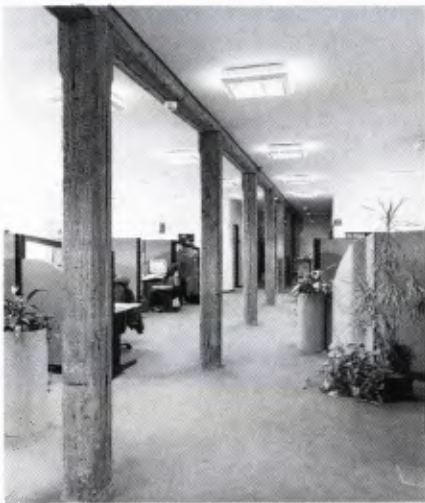
■ 6 Obergeschoß des Flügelbaues mit der hölzernen Stützenreihe nach dem Umbau.
