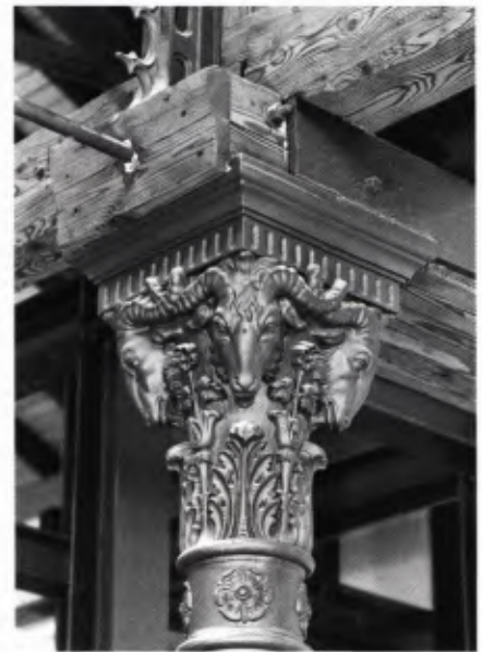
■ 4 Detail einer gußeisernen Stütze mit verzierten Auflagen.
