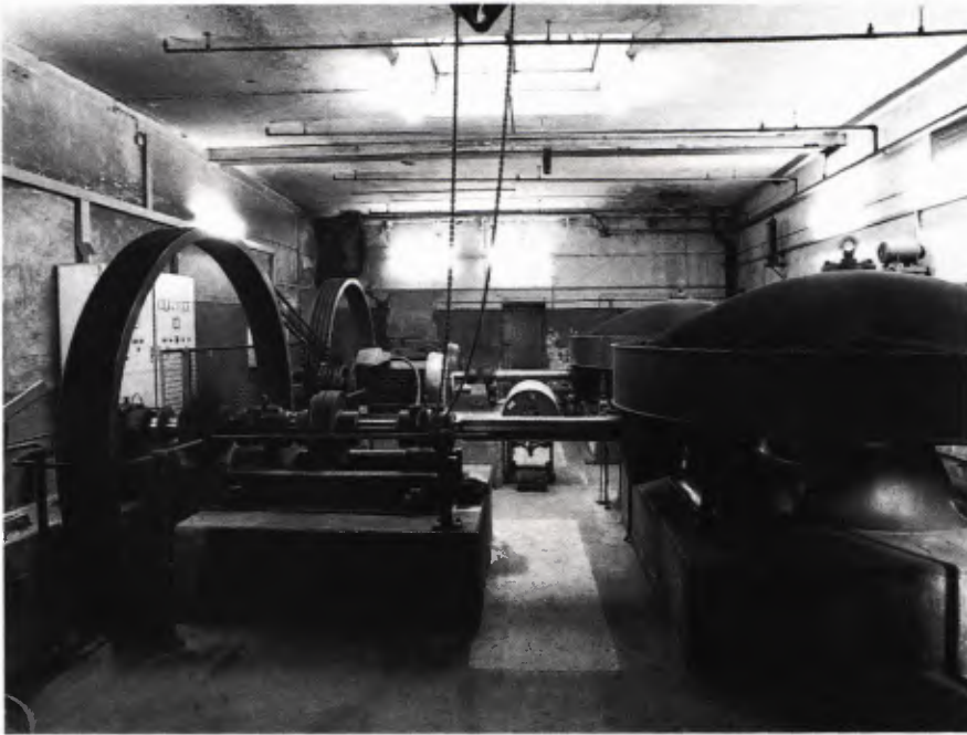
■ 2 Turbinenraum der Rommelmühle, Zustand 1996.
