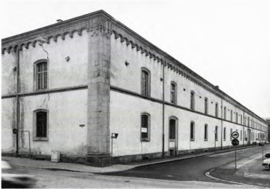
■ 1 Rastatt, Festungslazarett, Westfassade.
