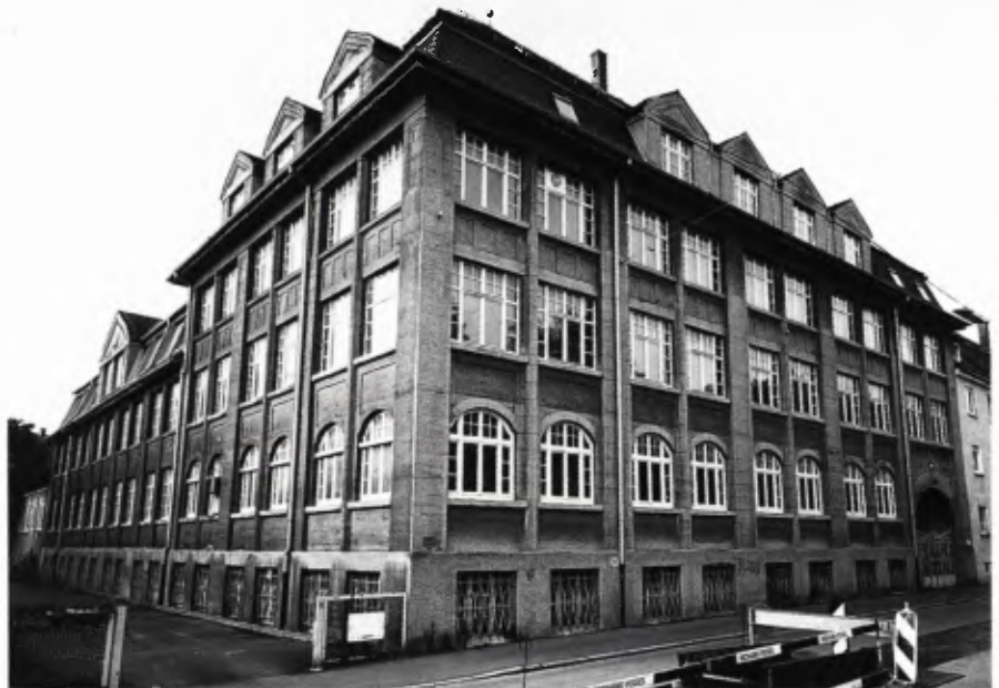
■ 1 Ulm, Blick von der Römerstraße auf das Fabrikgebäude der ehem. Schirmfabrik.
