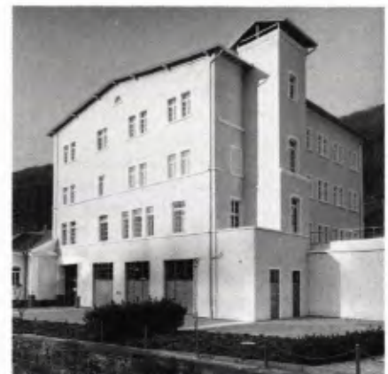
■ 9 Batteurbau nach seiner Instandsetzung und Freistellung von Nebenbauten.
