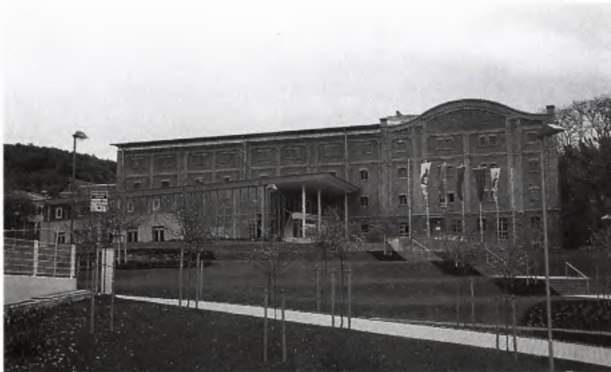
■ 1 Mosbach, Alte Mälzerei. Westfassade.
