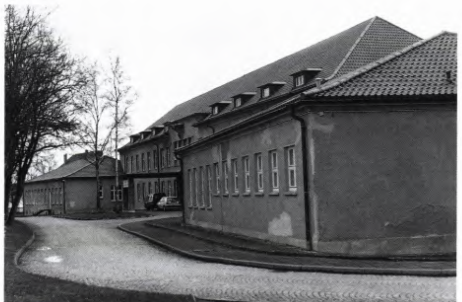
■ 5 Hauptzugang an der Nordseite mit trapezförmigem Vorplatz.
