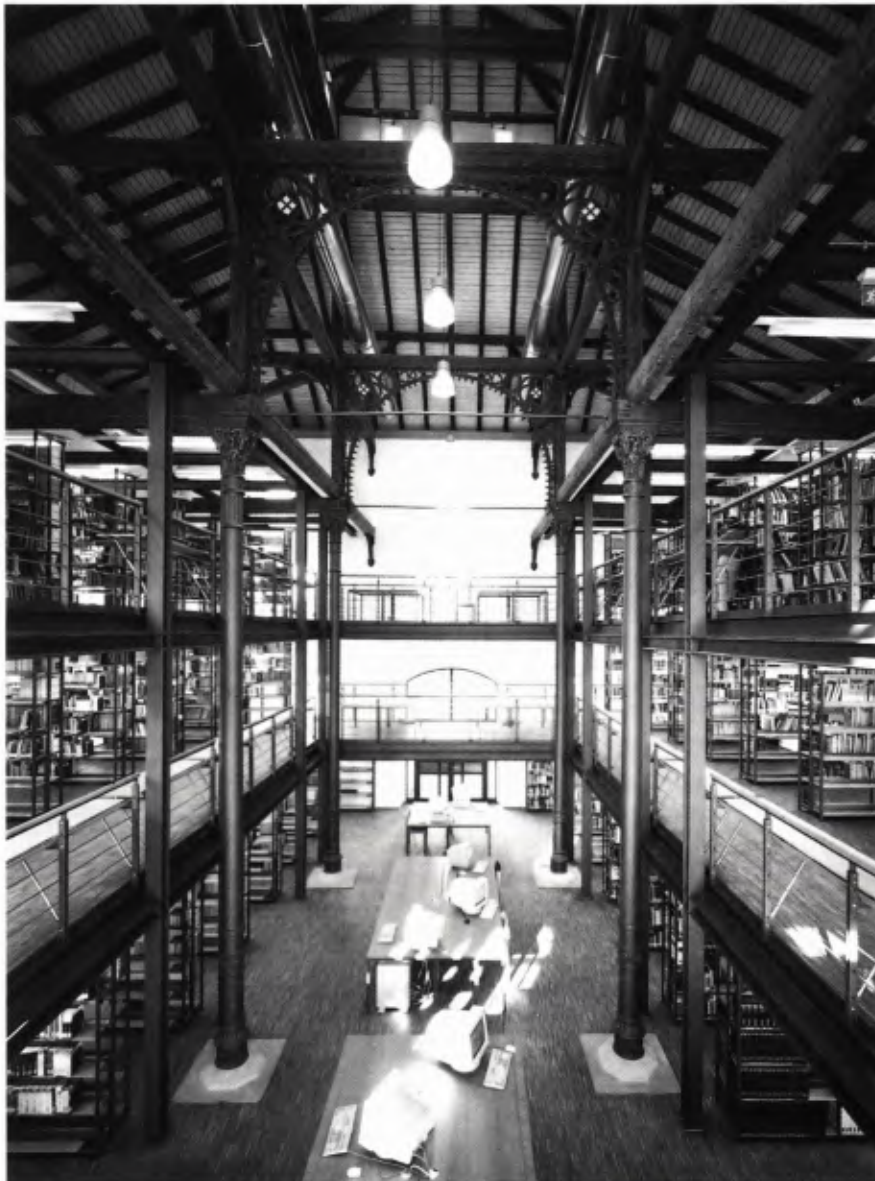
■ 3 Innenansicht der Freihandbibliothek mit den gußeisernen Stützen (der früheren Schlachthalle) und der unabhängigen Stahlkonstruktion für die Etagen der Bibliothek.
