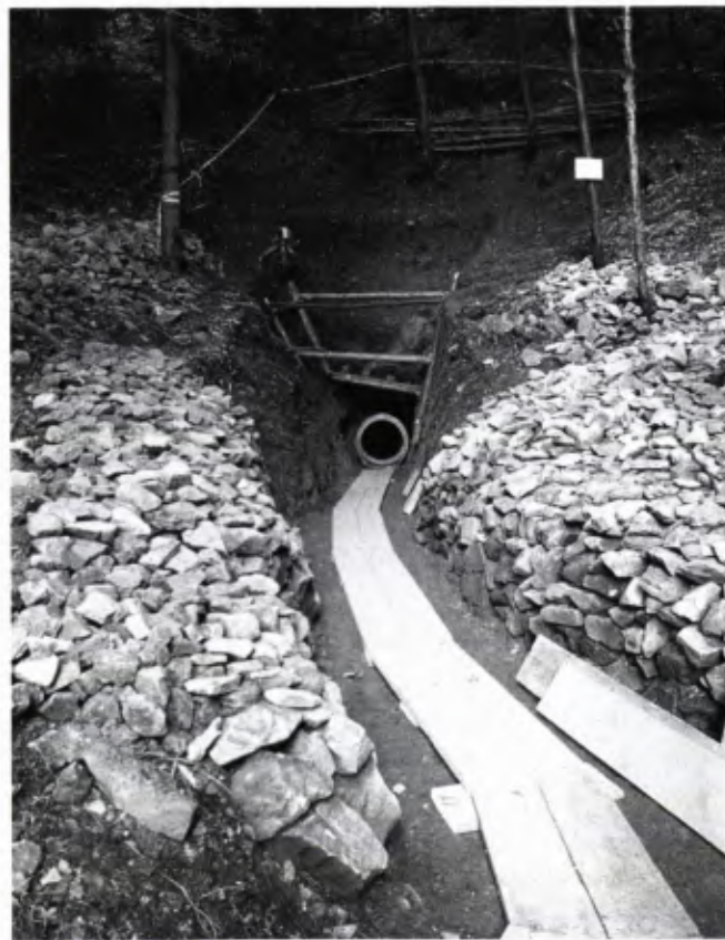
■ 11 Aufwältigung der mittelalterlichen Grube 2 am Birkenberg mit Sicherungsausbau im Mundlochbereich (Sommer 1997).
