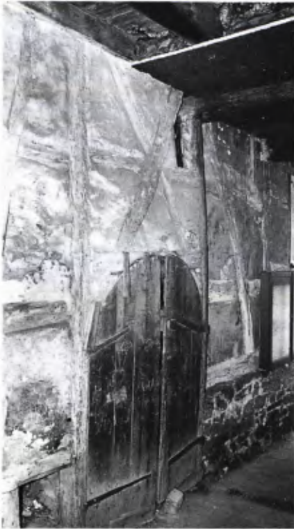
■ 5 Die Außenwand zur Durchfahrt von Kirchstraße 18 mit Kellertor und Andreas-kreuz. Photo: LDA Stuttgart.
