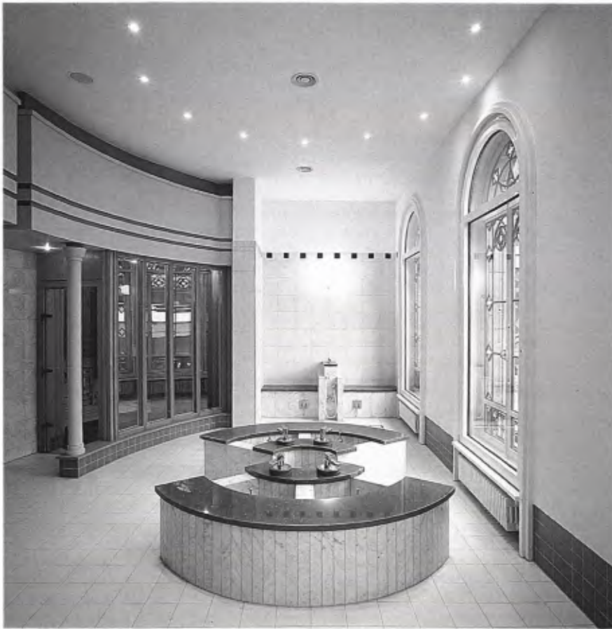
■ 16 Saunabereich im Obergeschoß: Die ehemalige hier ausgewiesene Hotelnutzung hatte die Originalsubstanz weitgehend eliminiert.
