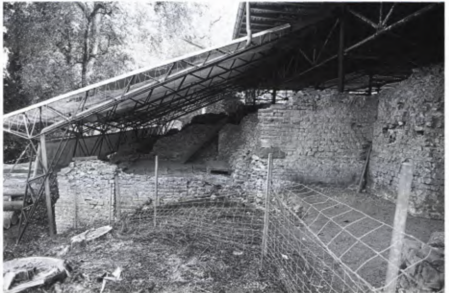
■ 8 Der Nordteil der Thermen mit seinem provisorischen Zeltdach.
